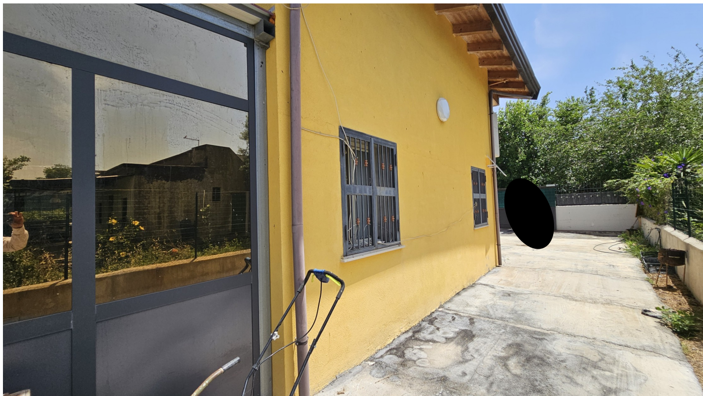
Foto 03 — Vista prospetto laterale lato nord-ovest
