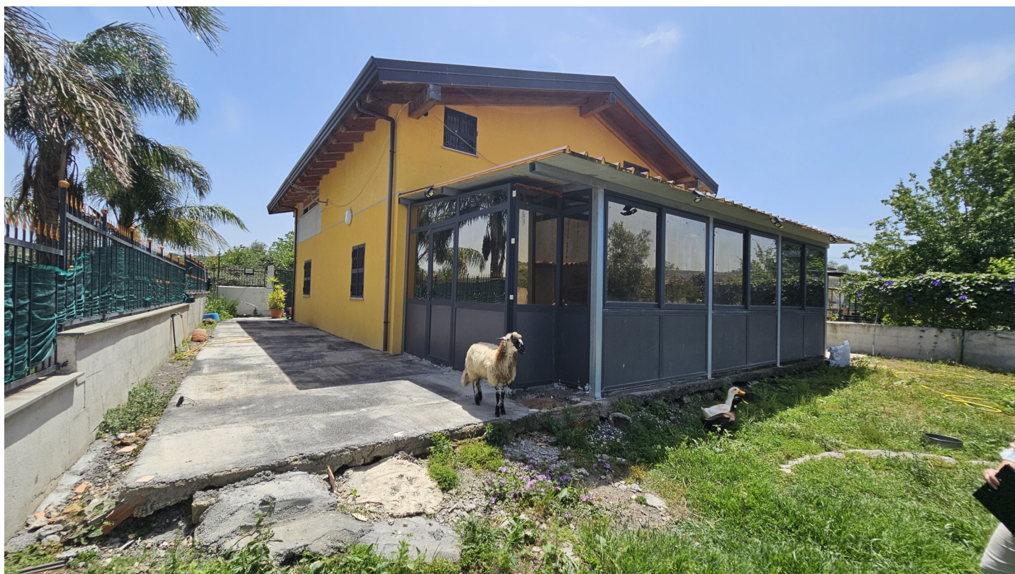
Foto 04 — Vista del prospetto laterale lato nord-est
