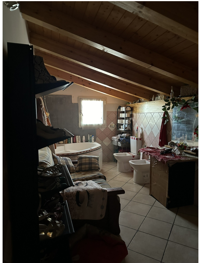
Foto 10 — Vista W.C. (piano primo)
