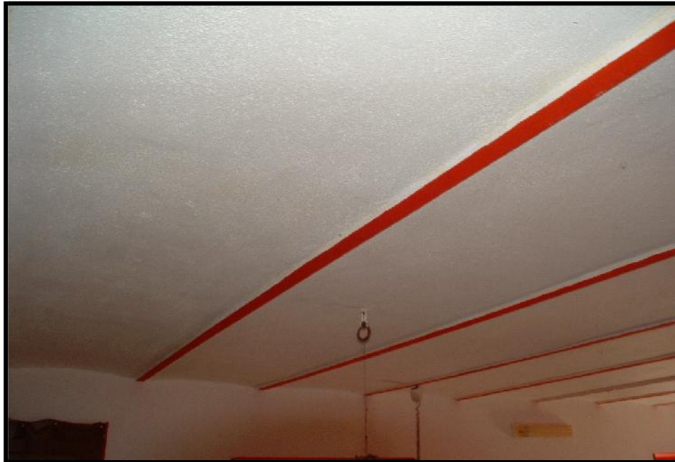
FOTO 8_ Particolare del solaio della sala principale al piano terra.
