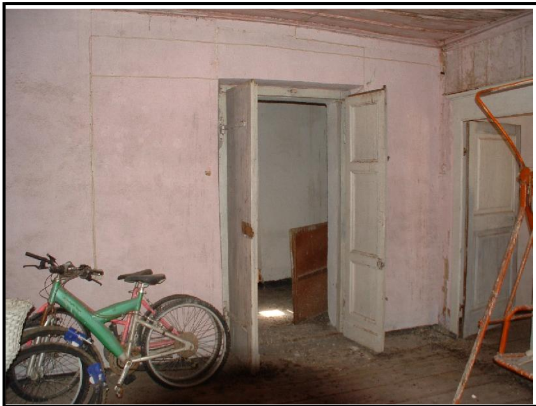
FOTO 21 - vista della soffitta
