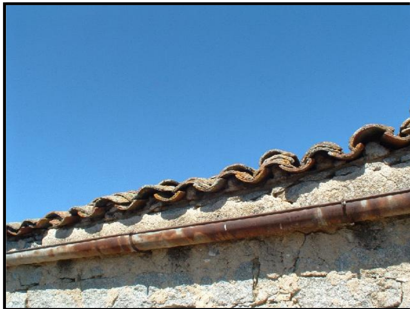
FOTO 26 – Particolare del cornicione.
