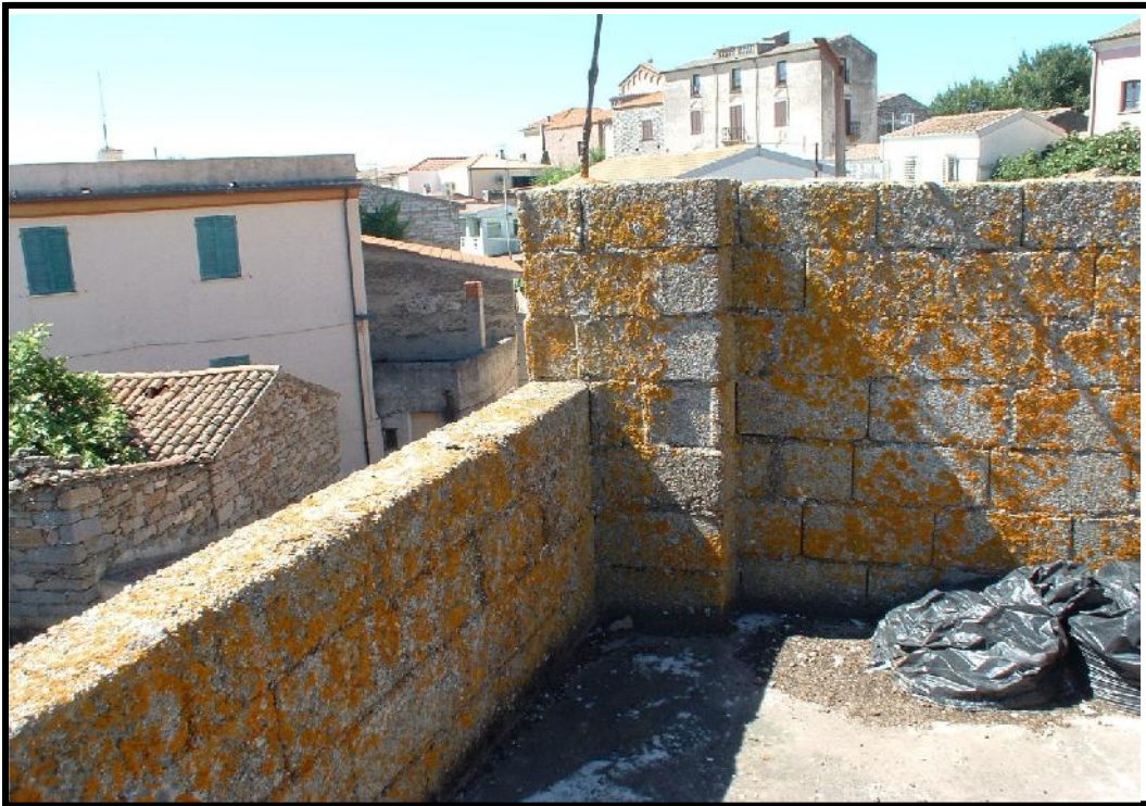
FOTO 25 - Parapetto della terrazza
