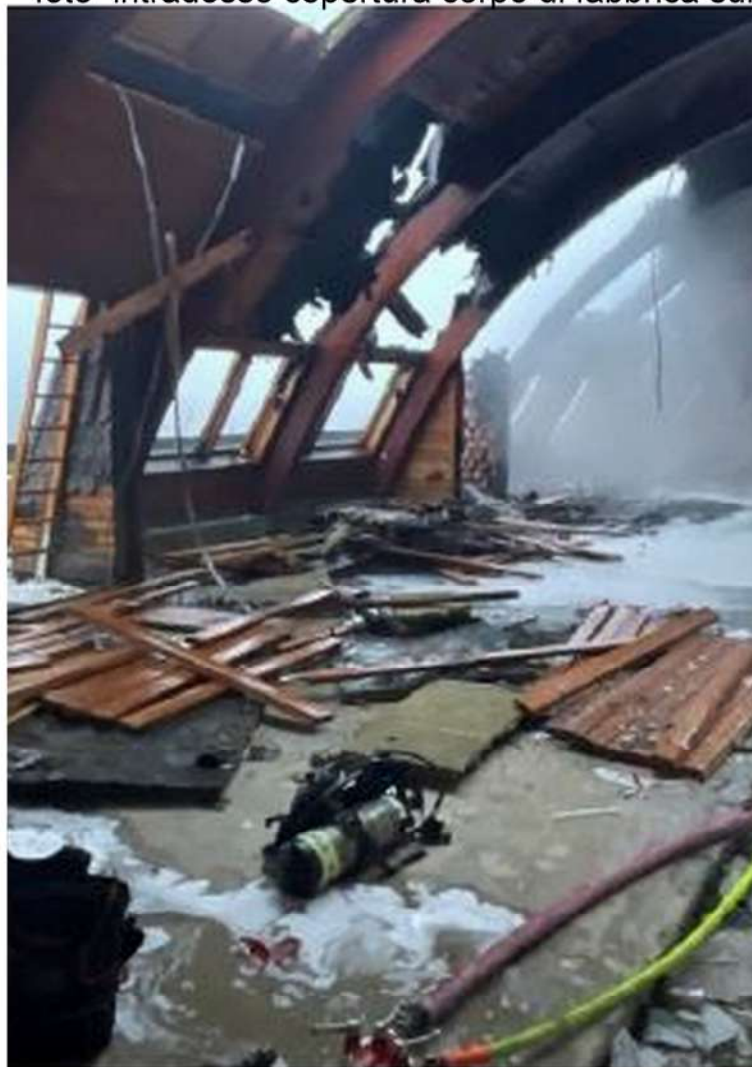
foto intradesso copertura post incendio del 19/01/2025
