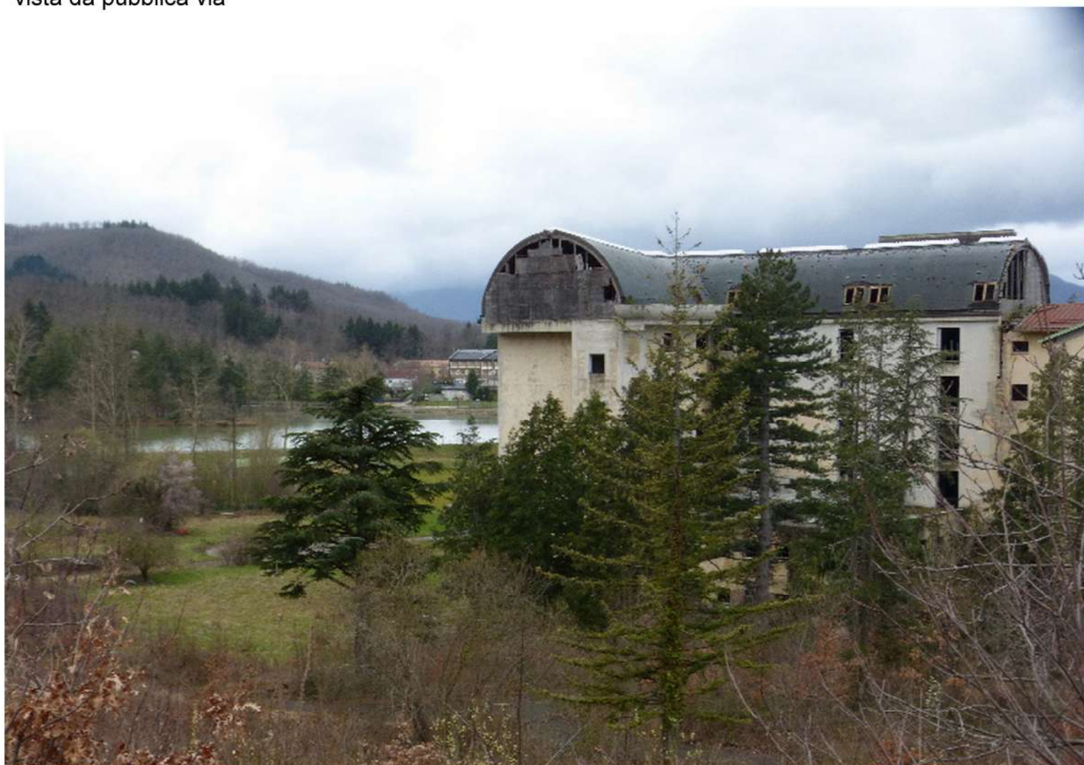
vista del retro edificio
