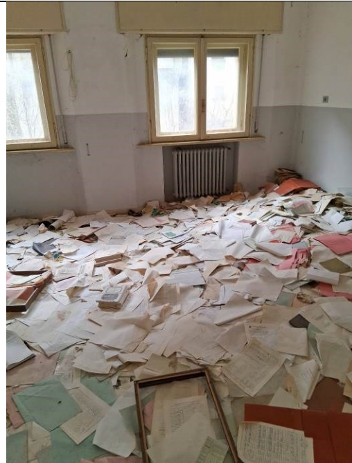
Vista interna edificio "A"
