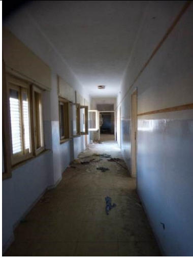
Vista interna edificio "A"
