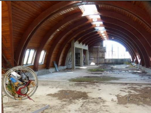
Ultimo piano dell'edificio "B" foto scattata in data 08/01/2025
