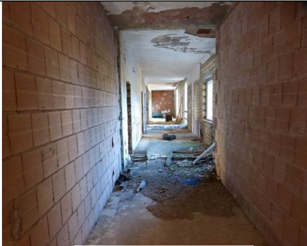
Vista dei corridoi interni dell'edificio "B"
