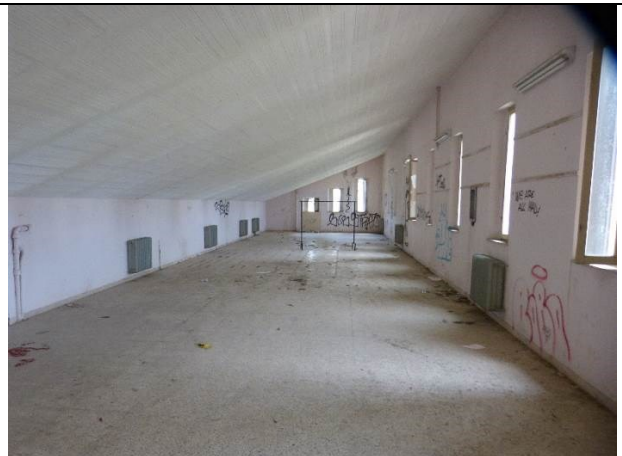
Vista piano sottotetto edificio "A"
