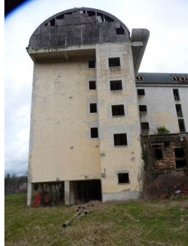
Prospetto lato est dell'edificio "B"
