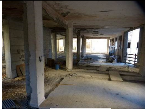
Vista interna corpo "C"
