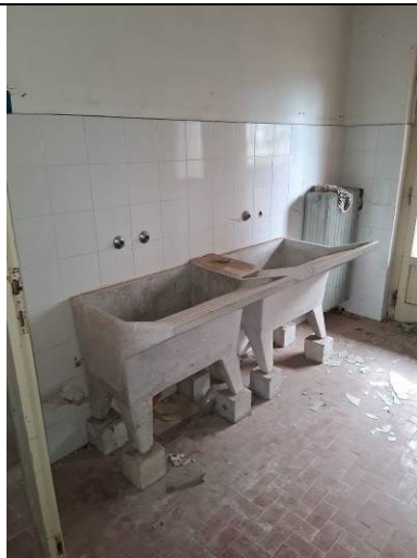
Lavanderia edificio "A"
