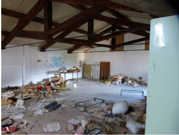
Sottotetto di una porzione dell'edificio "C" attigua all'edificio "A"
