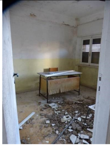
Vista interna edificio "A"
