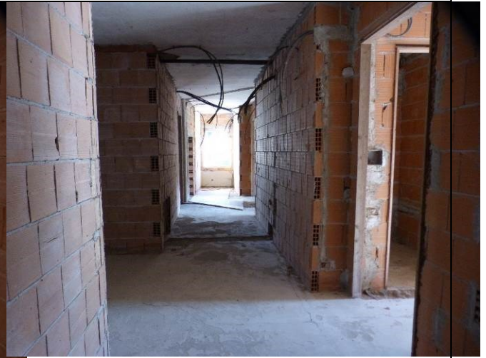
Vista interna dell'edificio "B"
