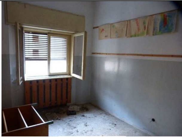
Vista interna edificio "A"
