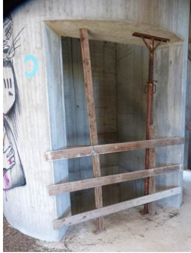
Vista del vano ascensore del corpo scale edificio "C"
