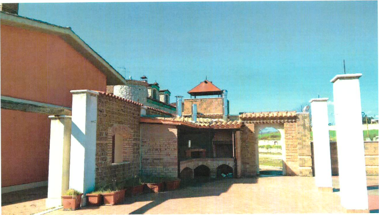
FOTO N. 25 - PIANO TERRA - PATIO A SERVIZIO DELL'INTERO COMPENDIO
