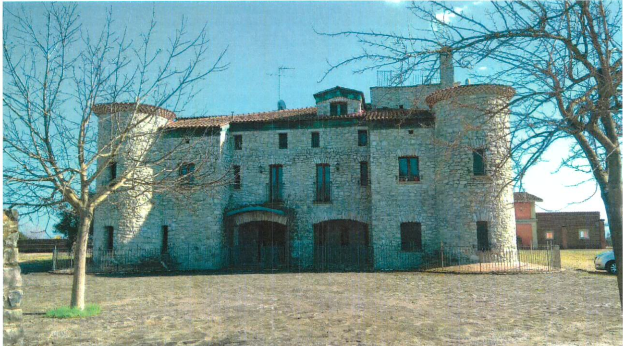
FOTO N. 4 - FABBRICATO A – PRINCIPALE - PROSPETTO ANTERIORE
