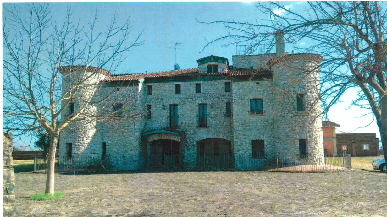
FOTO N. 4 - FABBRICATO A – PRINCIPALE - PROSPETTO ANTERIORE
