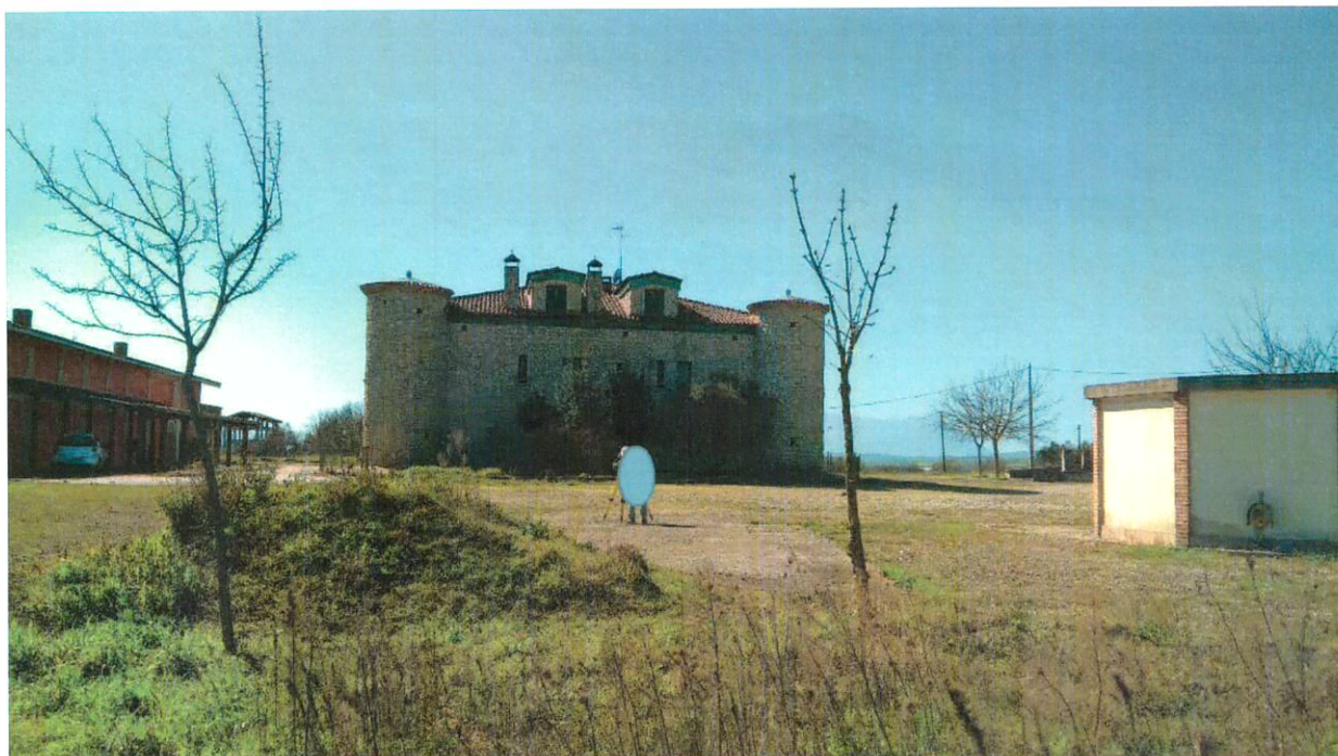
FOTO N. 7 - PROSPETTO LATERALE - FABBRICATO A-
