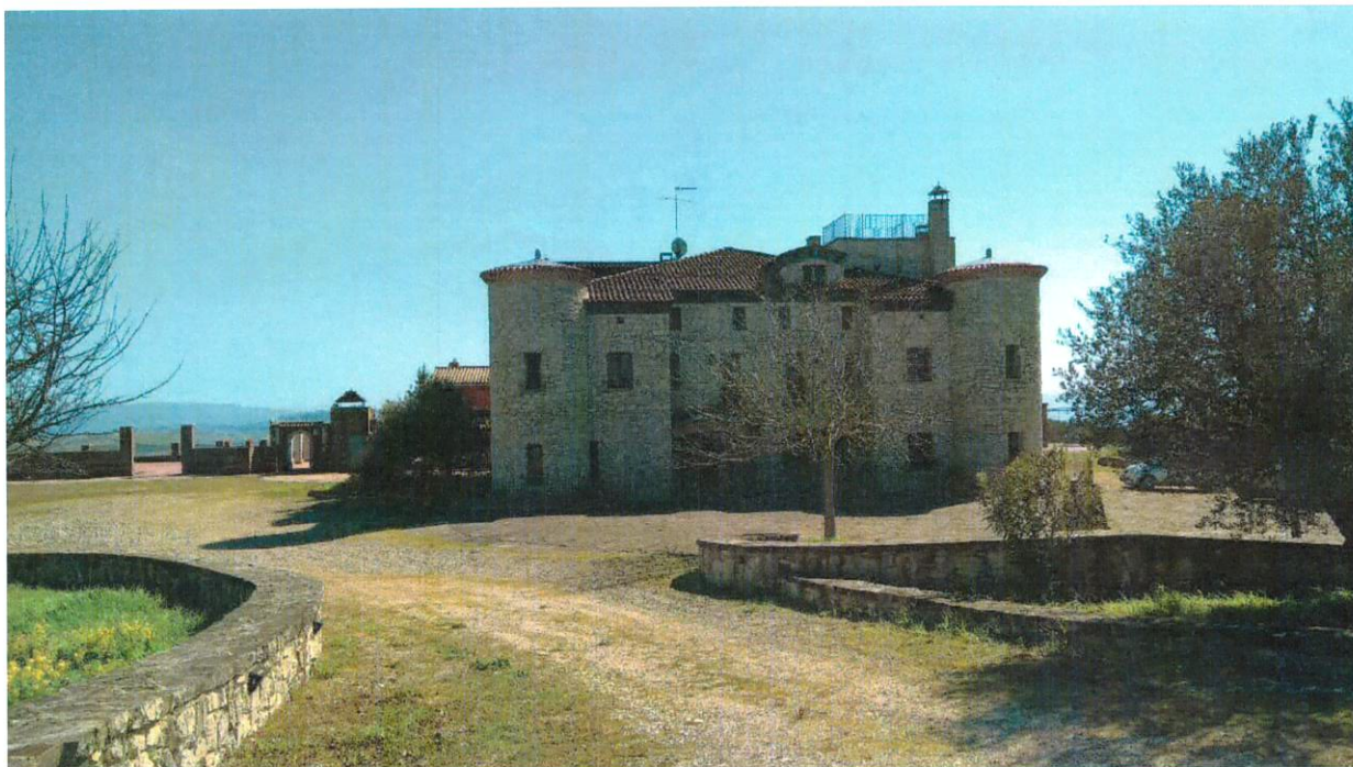
FOTO N. 3 - FABBRICATO A - PRINCIPALE - PROSPETTO ANTERIORE
