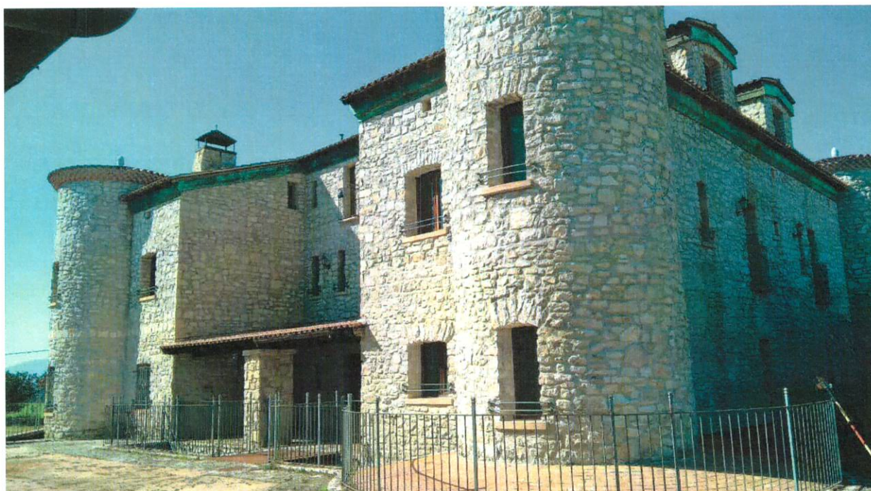
FOTO N. 8 - PROSPETTO - FABBRICATO A
