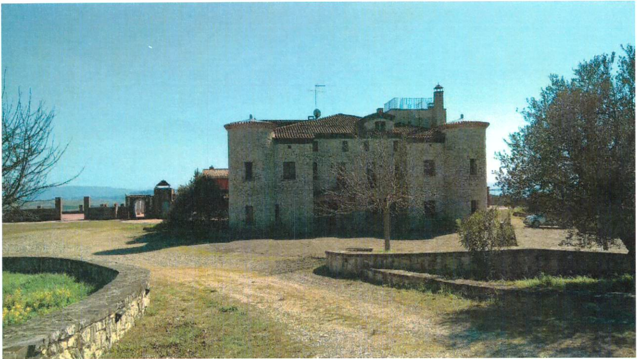
FOTO N. 3 - FABBRICATO A - PRINCIPALE - PROSPETTO ANTERIORE
