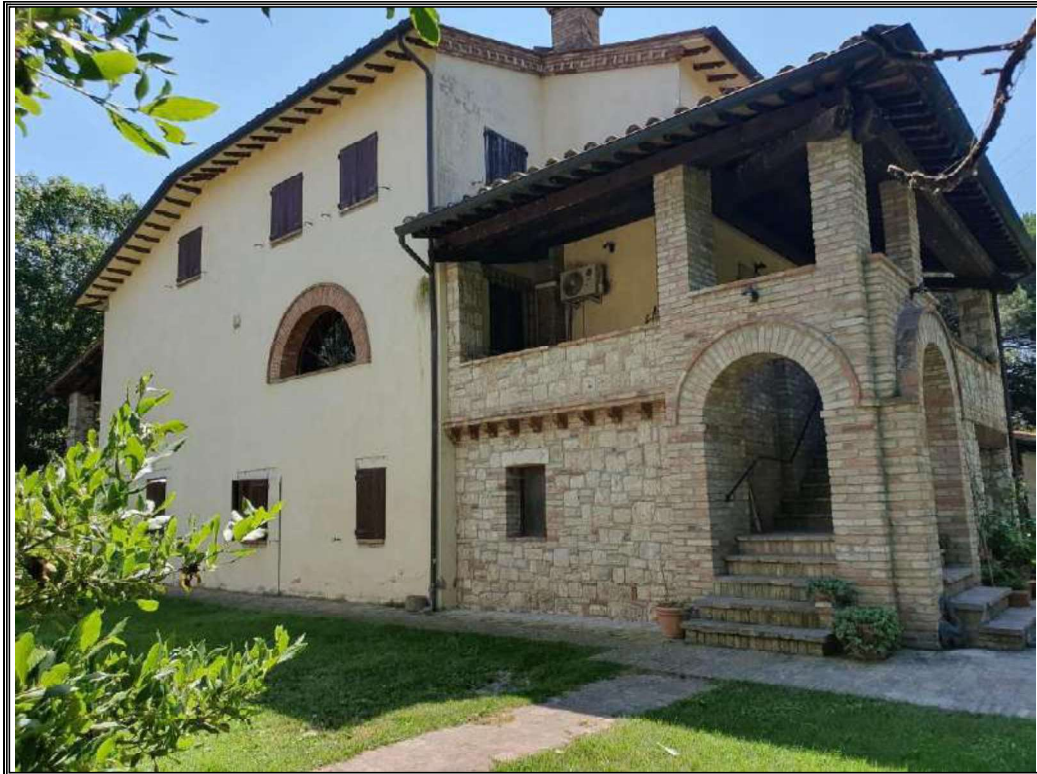
Foto n. 35 LOTTO 2 part. 1044 sub 4 e 5 - vista esterna fabbricato abitativo
