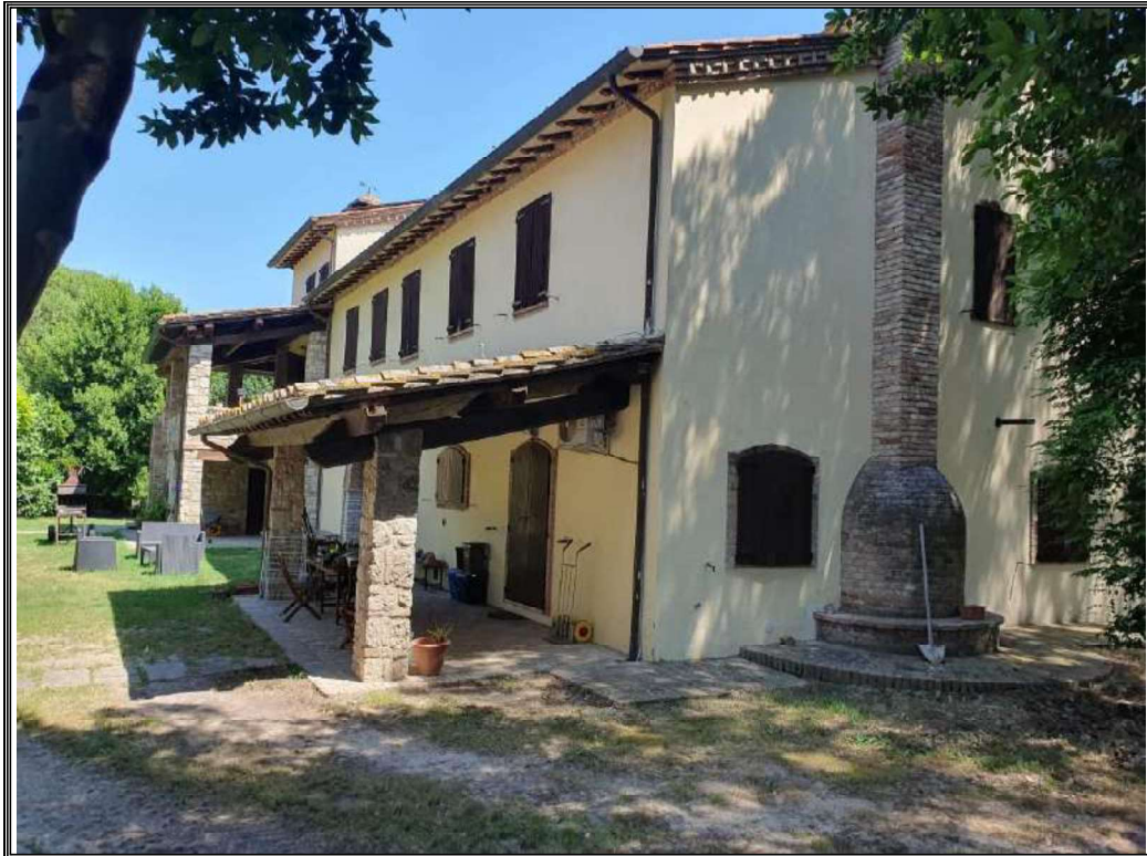
Foto n. 33 LOTTO 2 part. 1044 sub 4 e 5 - vista esterna fabbricato abitativo
