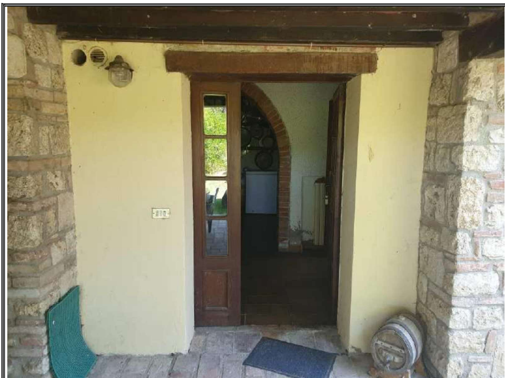
Foto n. 36 LOTTO 2 part. 1044 sub 4 - ingresso al rustico
