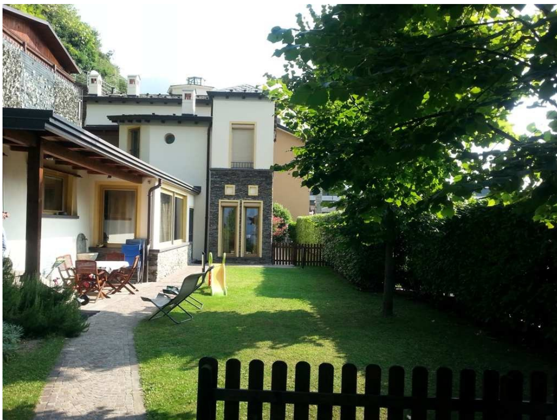
Vista generale area ad ovest dell'unità mapp. 305 sub. 6
