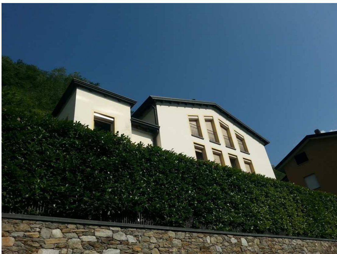
Vista generale del fronte sud dell'unità mapp. 305 sub. 6
