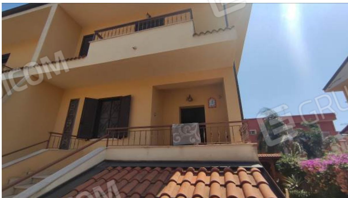
Foto n° 4: Ingresso principale unità immobiliare
