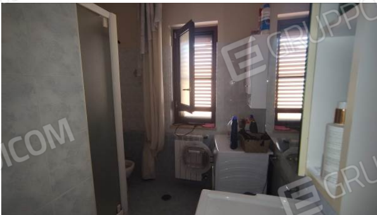
Foto n° 42: Piano Primo – servizio igienico secondario
