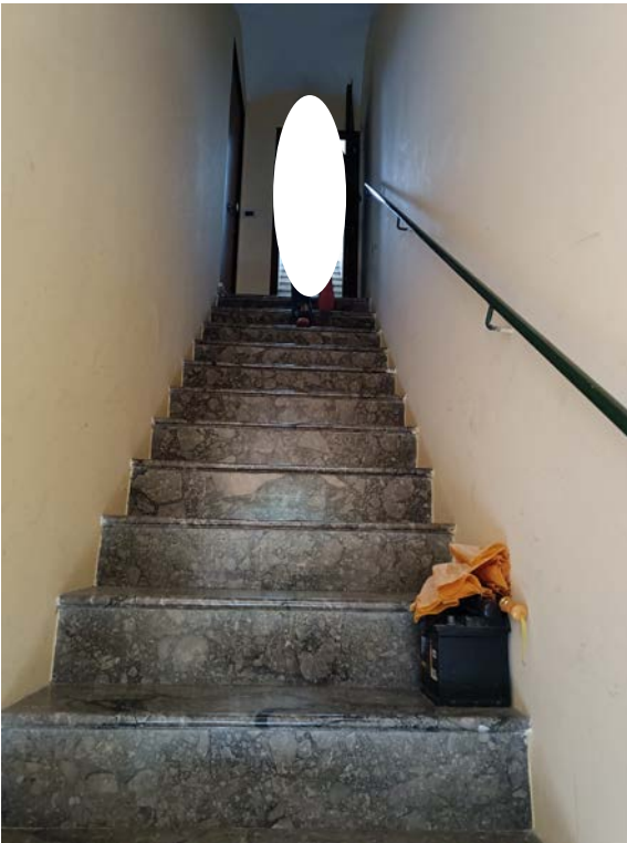
Foto n. 3 – Vista del corpo scala
