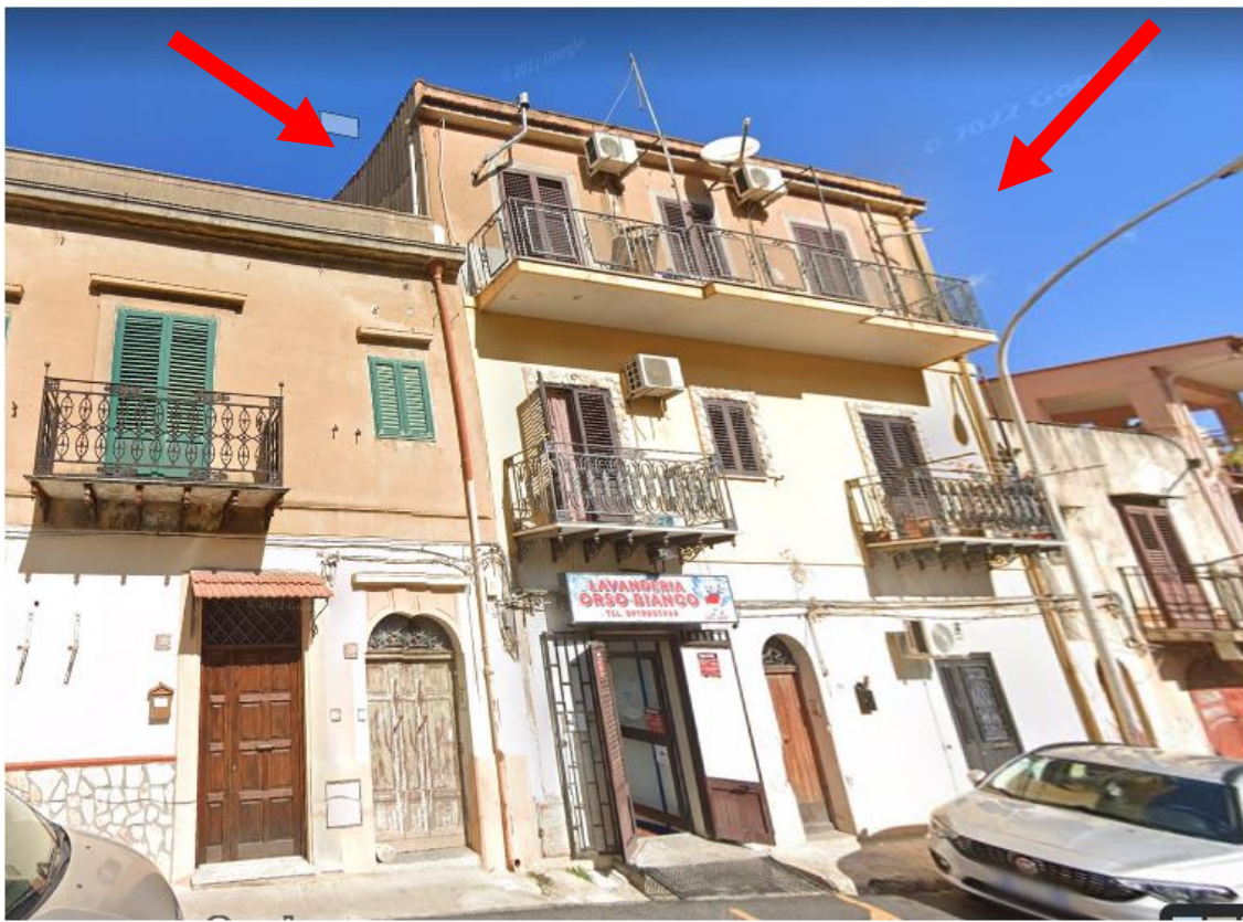
Foto n. 1 – Vista dell'intero immobile
