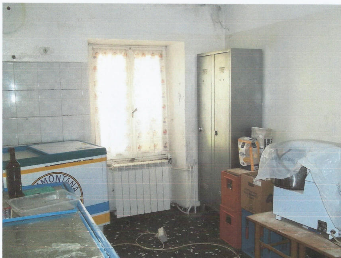
VISTA DEPOSITO SECONDO PIANO
