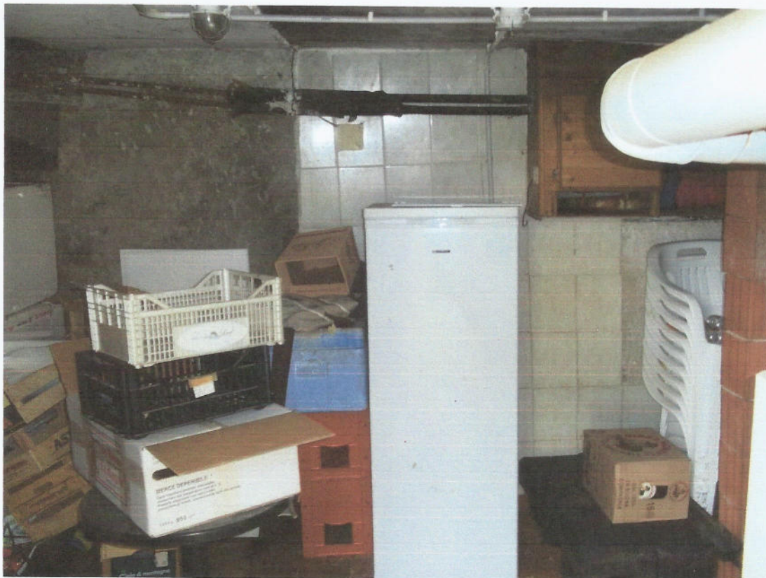
VISTA LOCALE CALDAIA PIANO SEMINTERRATO
