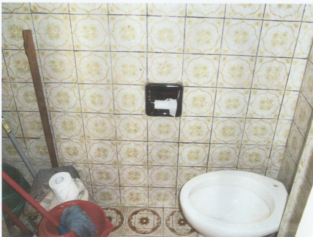
VISTA WC SECONDO PIANO
