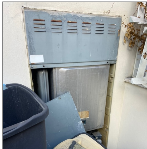
Caldaia a incasso esterna
