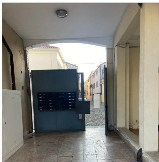
L'ingresso da Via Dalla Vedova - vista dall'interno
