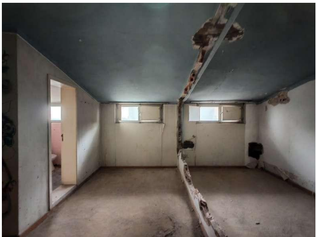
DEMOLIZIONE DI MURO DI DIVISIONE TRA DUE CAMERE DEL PERSONALE
