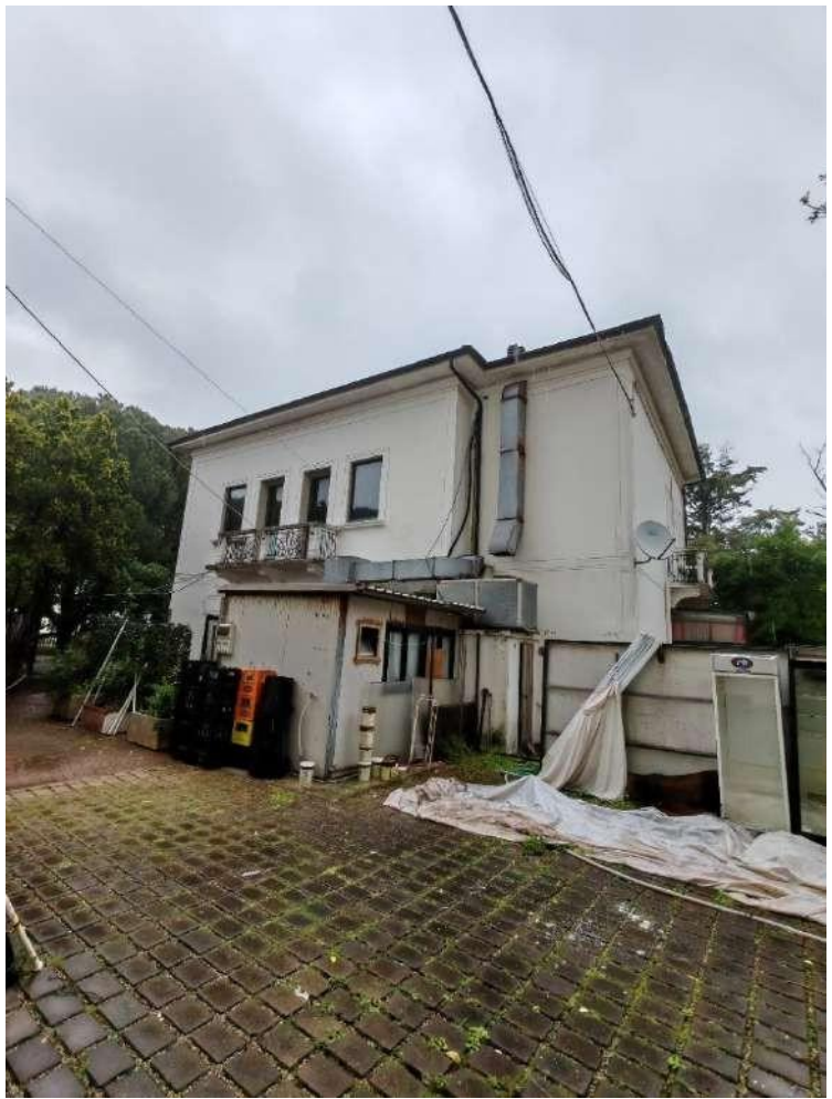
FRONTE LATO MONTE
