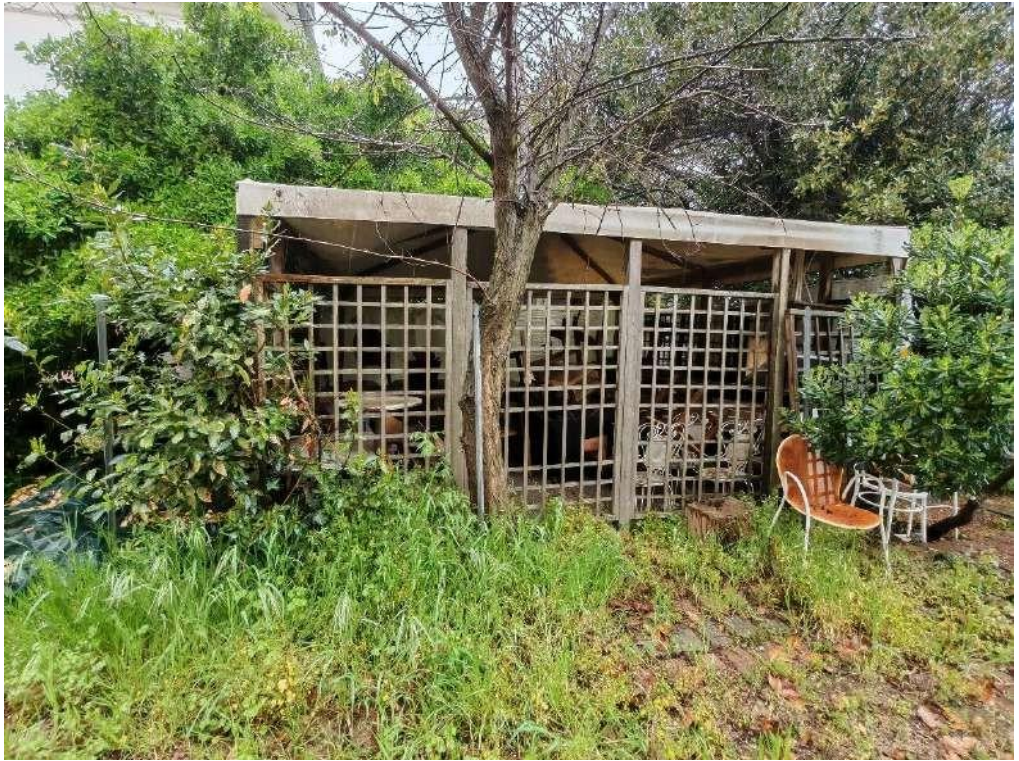
PERGOLATO REALIZZATO SENZA AUTORIZZAZIONE SULLA CORTE COMUNE SUB 89
