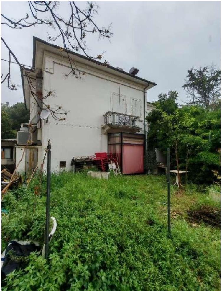
FRONTE LATO MISANO
