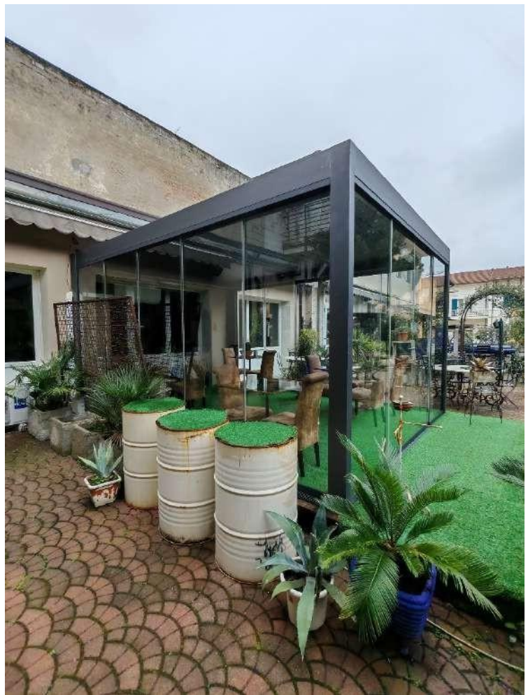
PERGOTENDA REALIZZATA SENZA AUTORIZZAZIONE
