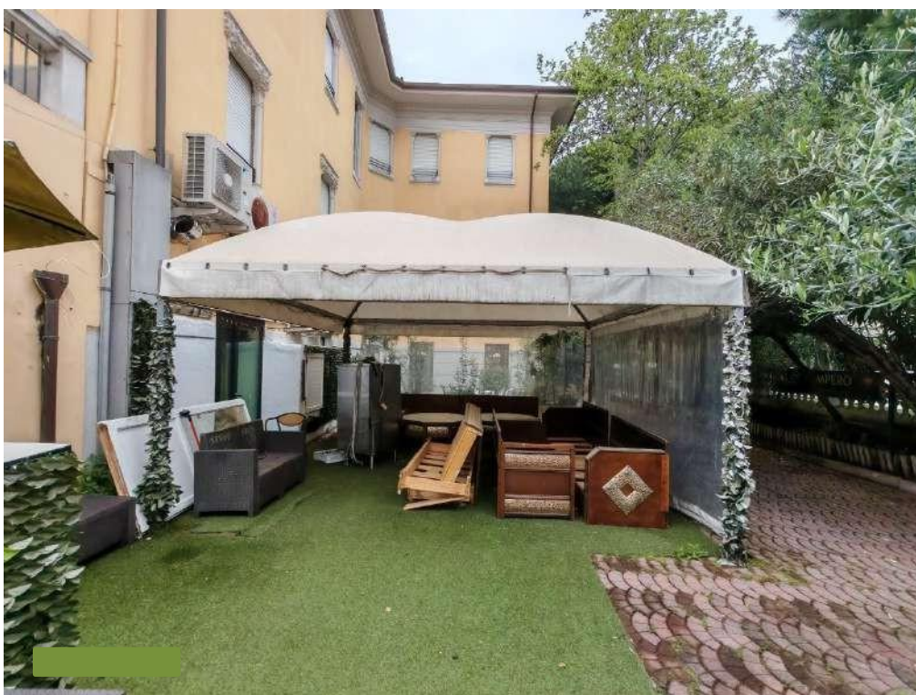
AREA ESTERNA CON GAZEBO NON AUTORIZZATO
