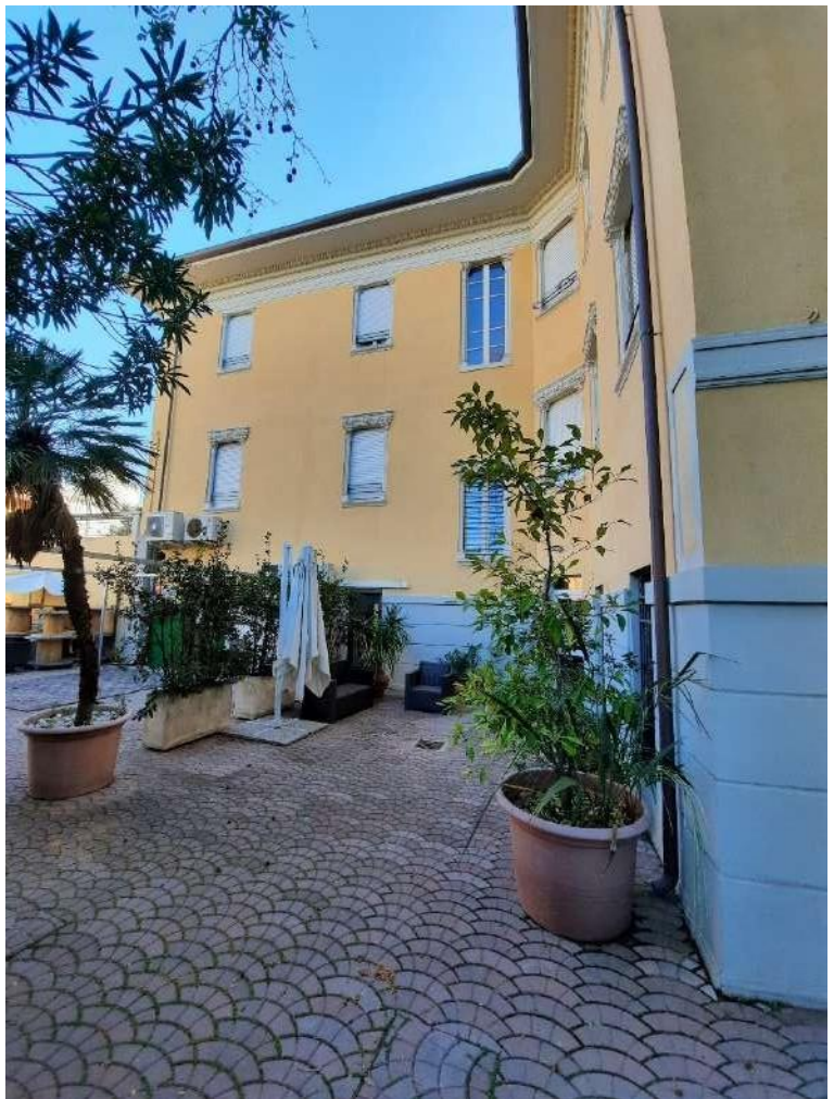
FRONTE VERSO LA PISCINA
