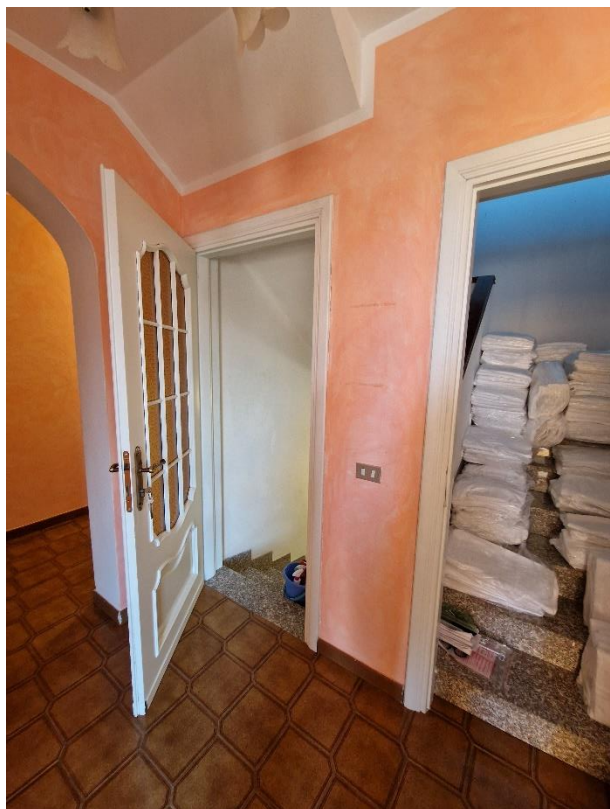
Disimpegno alla scala piano primo lotto 2
