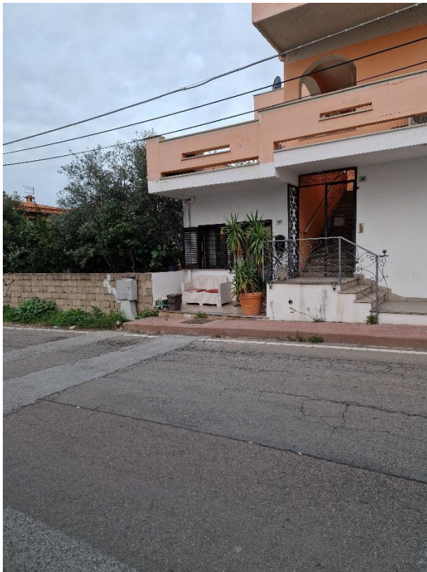
Ingresso da Via Tre Venezie Lotto 1
