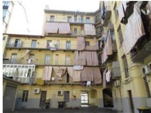
facciata lato cortile
