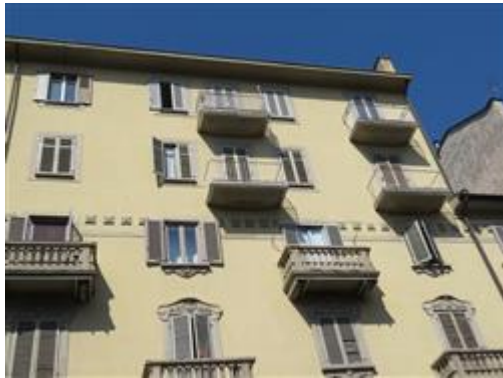
facciata lato via Feletto - dettaglio
