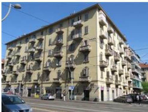
vista esterna dell'edificio
