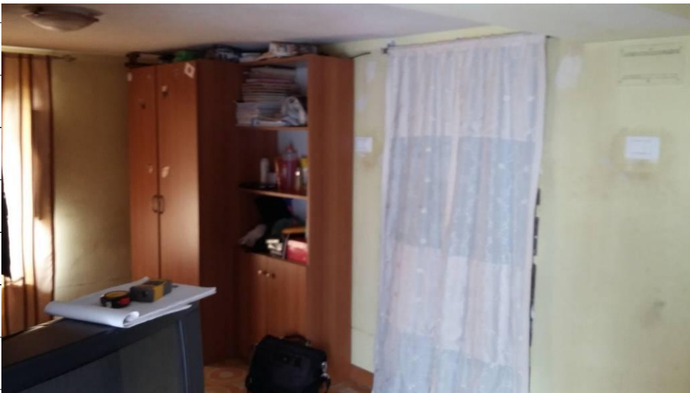
Foto 6 - LOTTO A_Ingresso dal vano scala (Piano terra)
