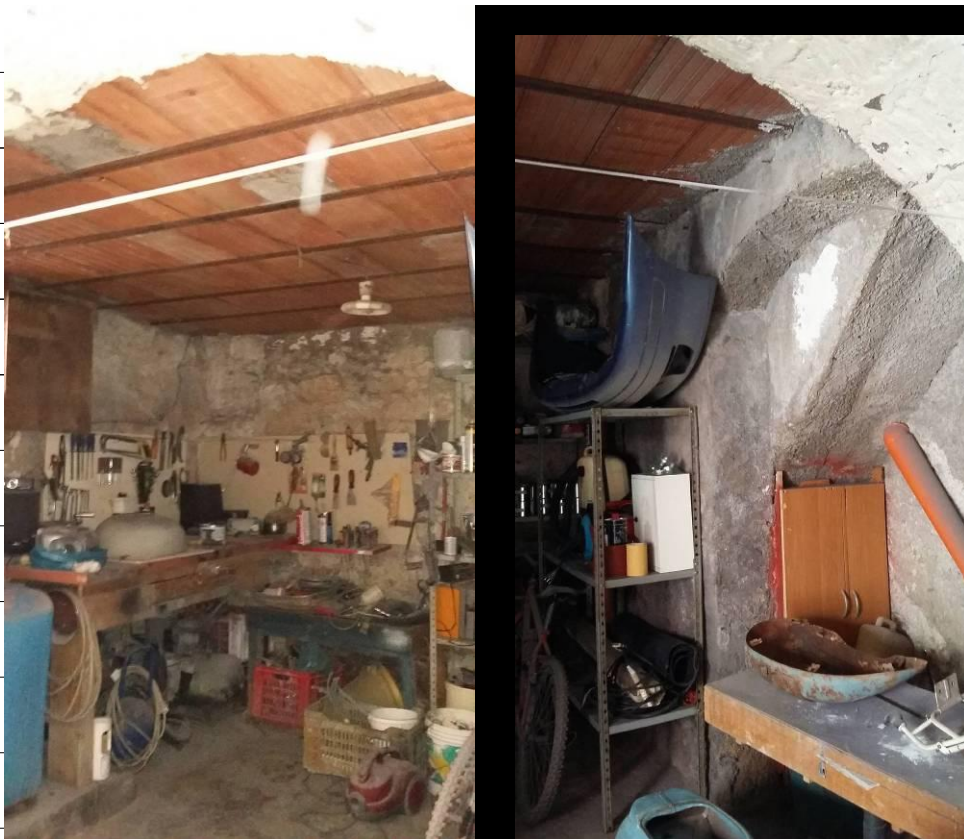
Foto 19- LOTTO B_Vano garage direzione sud-est.
