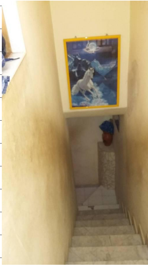
Foto 18 - LOTTO A_Seconda rampa di scala tra il piano terzo e quarto.
