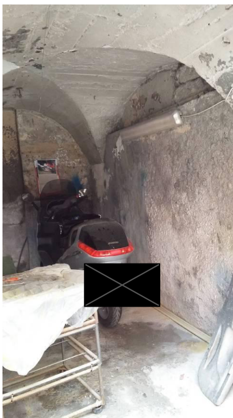
Foto 22- LOTTO B_ Vano garage.direzione nord-est, l'accesso.
