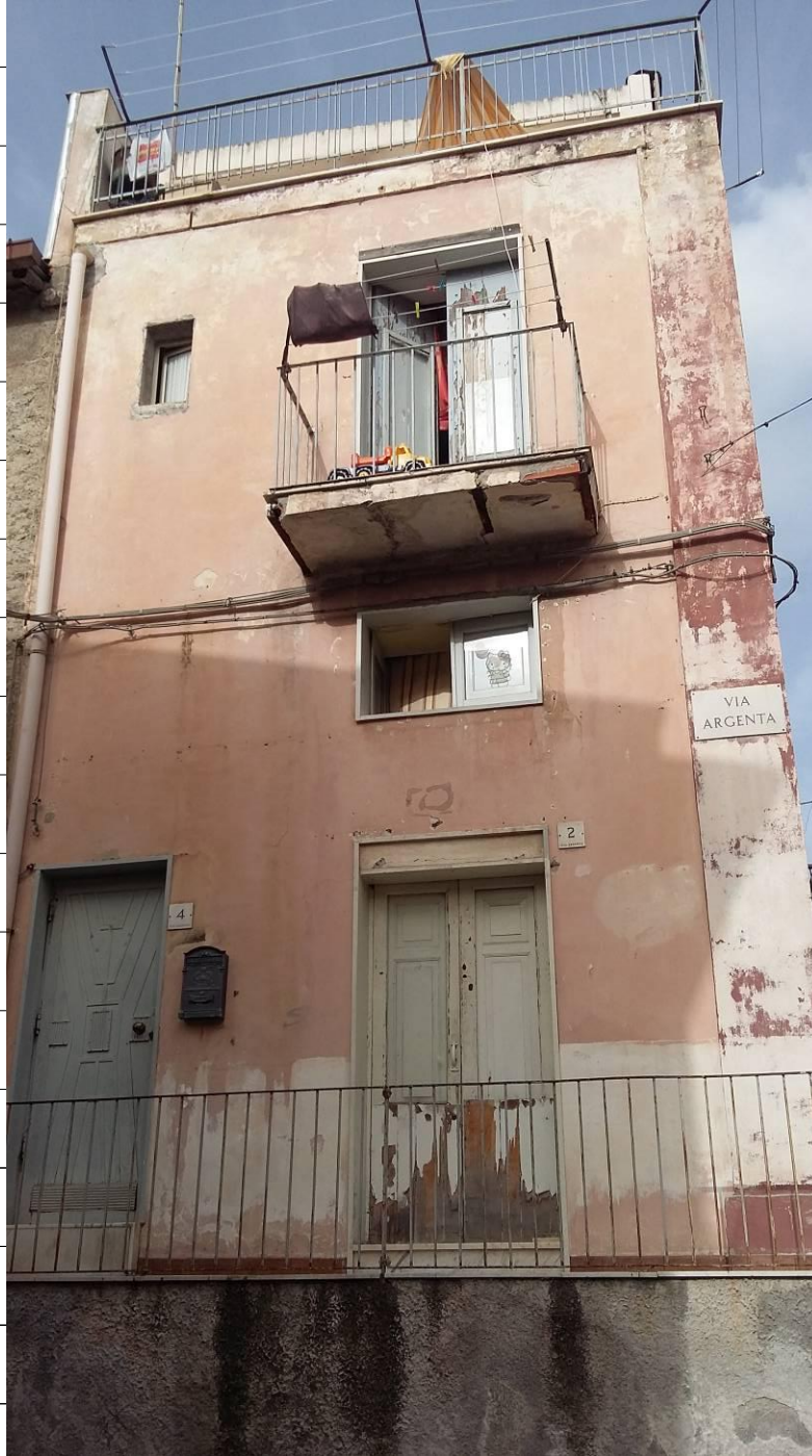
Foto 1 - Prospetto su Via Argenta
