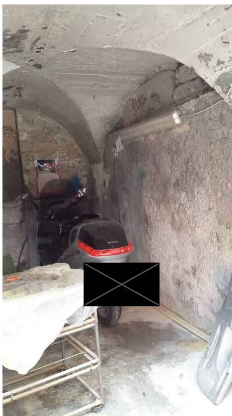
Foto 22- LOTTO B_ Vano garage.direzione nord-est, l'accesso.
