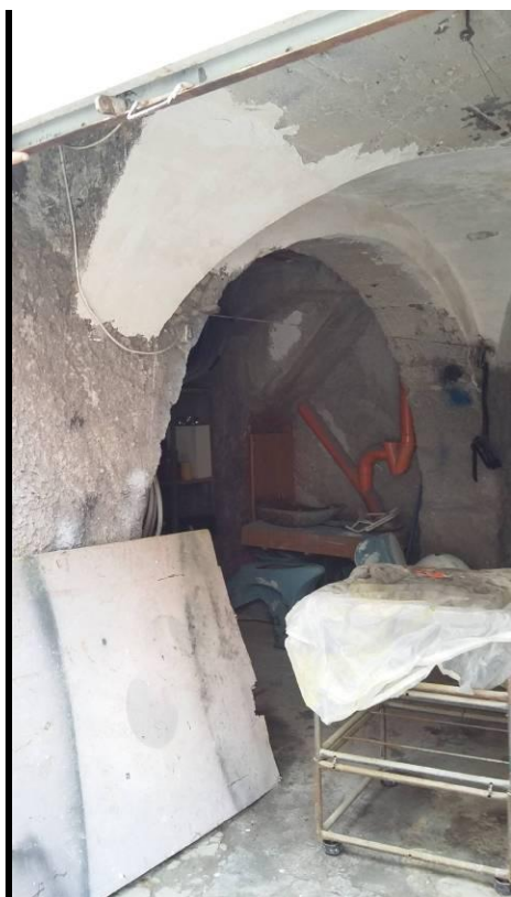
Foto 20-21- LOTTO B_ Vano garage.
