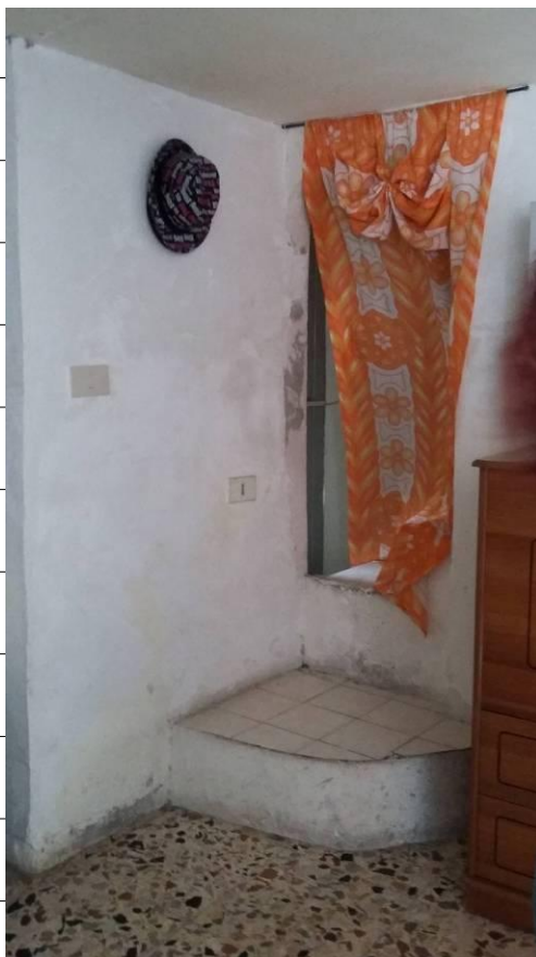
Foto 3 - LOTTO A_Ingresso dal vano scala (Piano terra)
