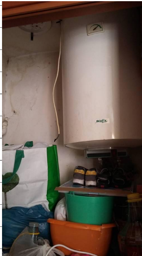
Foto 15 - LOTTO A_WC3 (Piano quarto)
