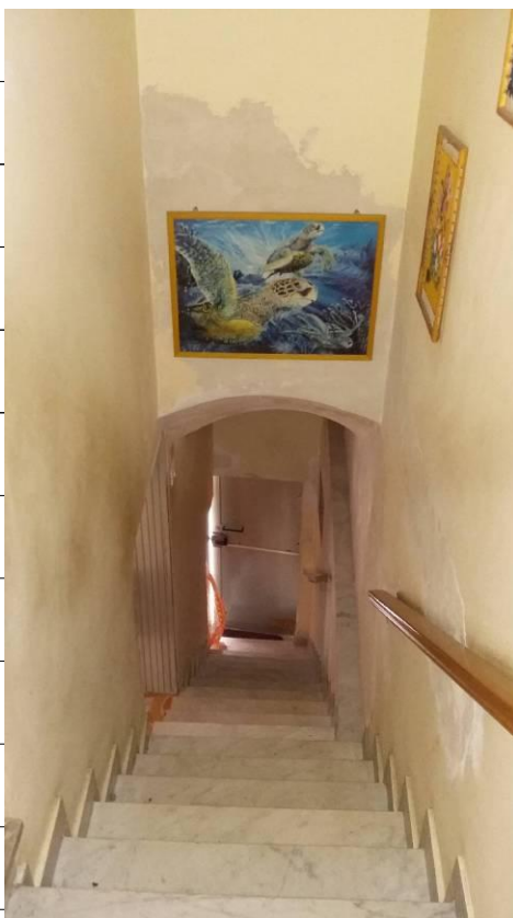
Foto 17 - LOTTO A_Prima rampa di scala di collegamento tra piano 1°,2° e 3°.
