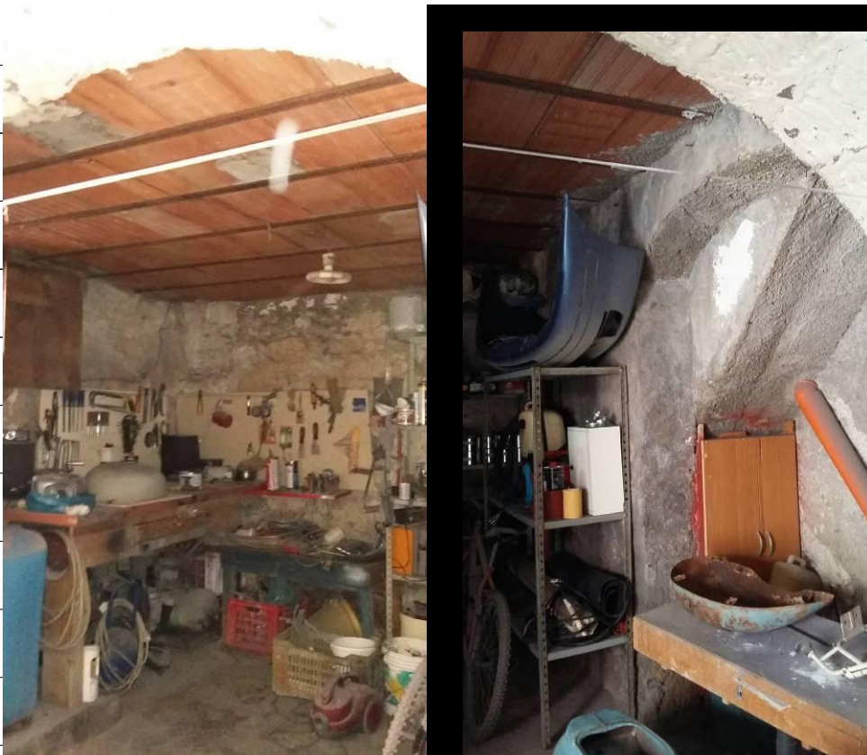
Foto 19- LOTTO B_Vano garage direzione sud-est.
