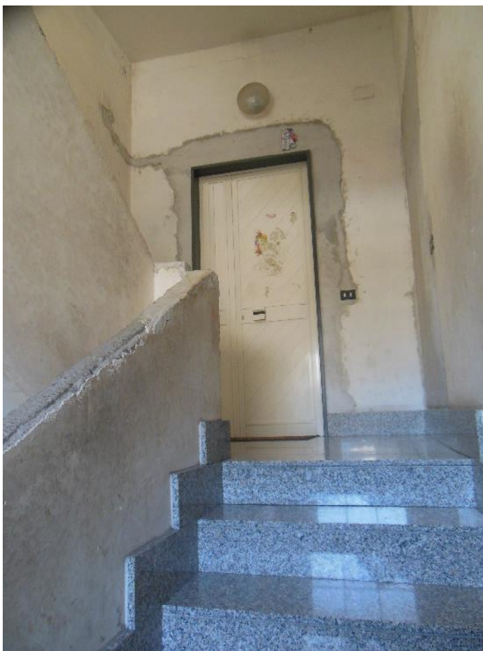
Foto 6 - Vista interna fabbricato: porta di ingresso appartamento pignorato piano 1
