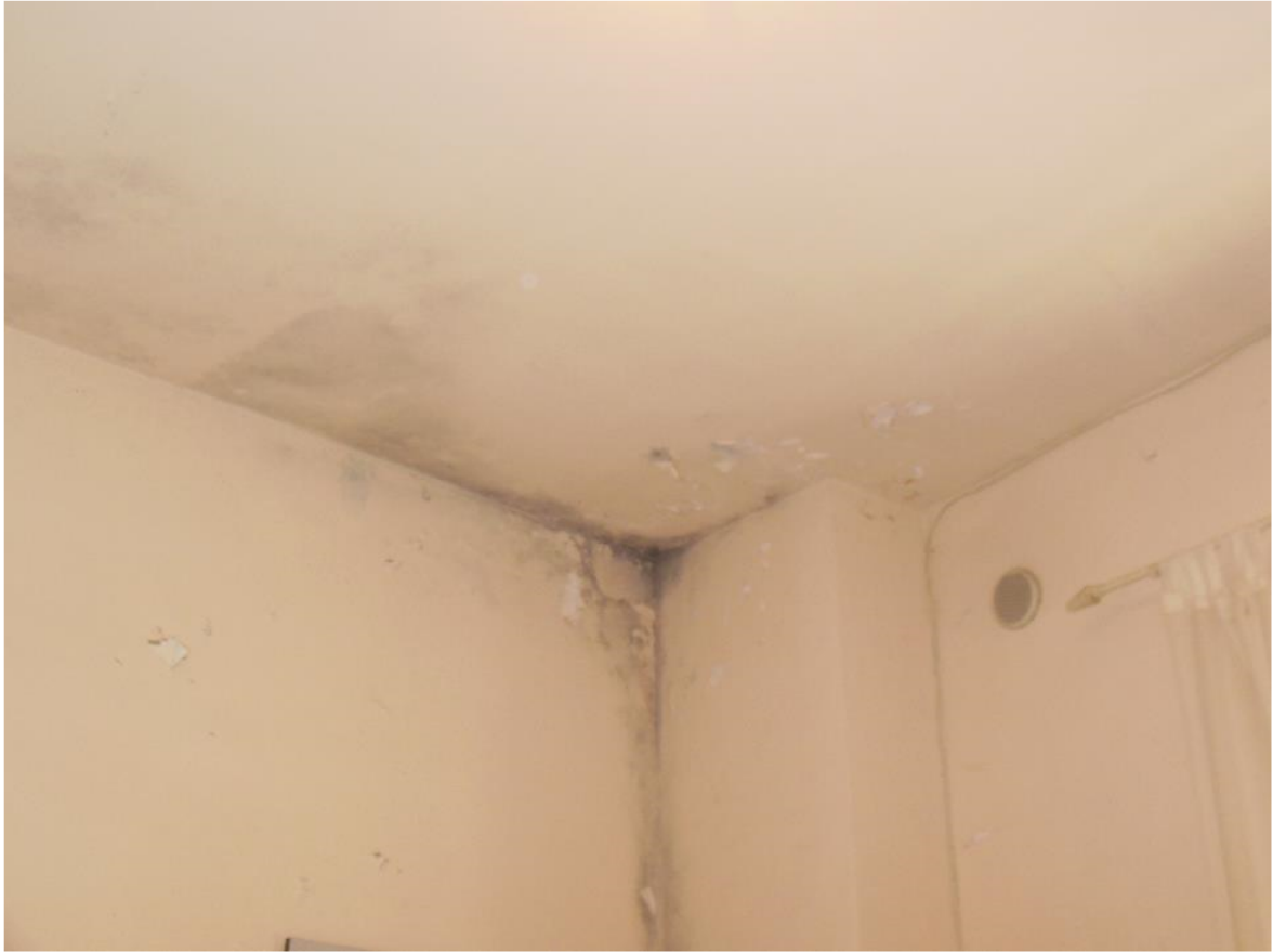
Foto 23 - Vista interna camera n. 1: dettaglio attacco parete/soffitto lato ovest
