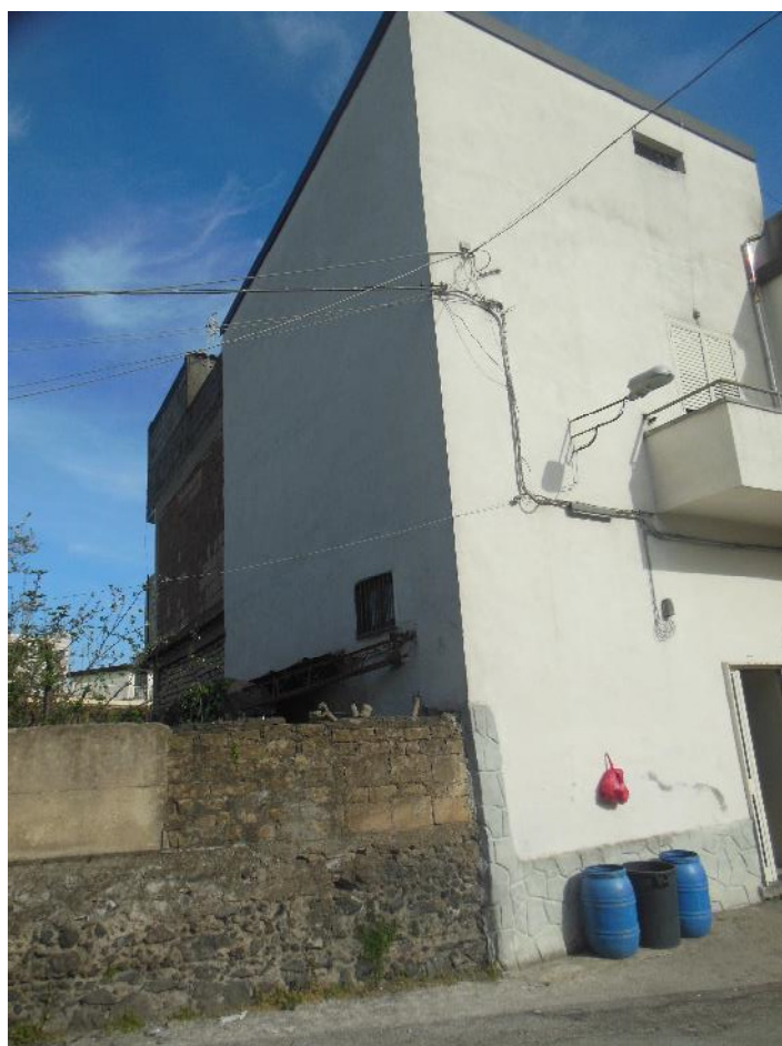
Foto 4 – Vista esterna fabbricato: dettaglio prospetto laterale
