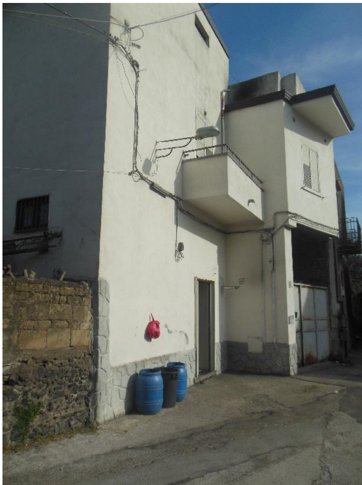
Foto 3 – Vista esterna fabbricato: dettaglio prospetto principale
