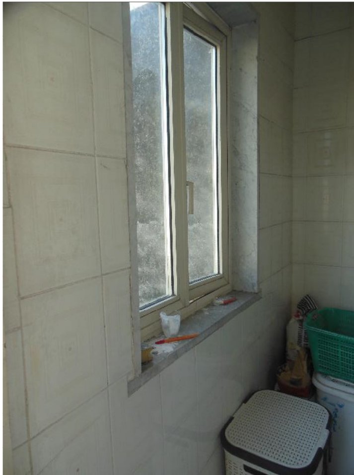
Foto 17 – Vista interna ripostiglio balcone n. 2: dettaglio finestrino
