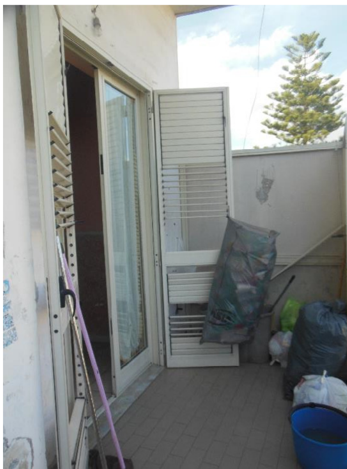
Foto 20 - Vista esterna balcone n. 2: dettaglio porta-finestra cucina
