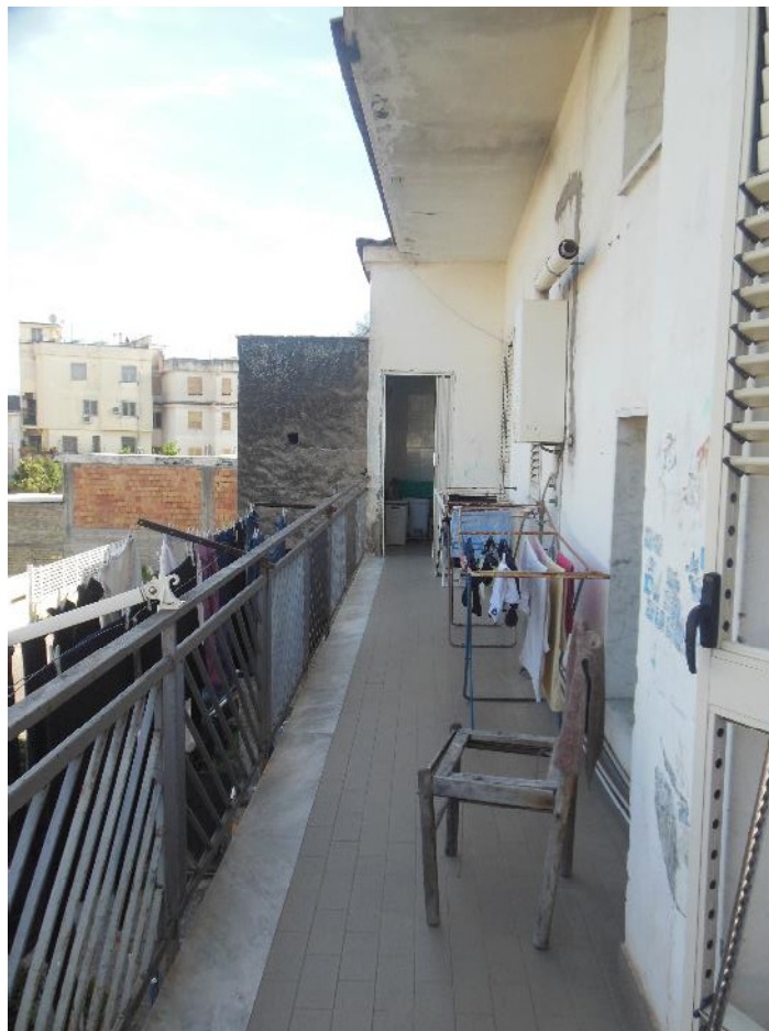
Foto 15 – Vista esterna: balcone n. 2 lato cucina, w.c., camera n. 3
