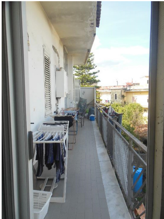
Foto 18 - Vista esterna balcone n. 2
