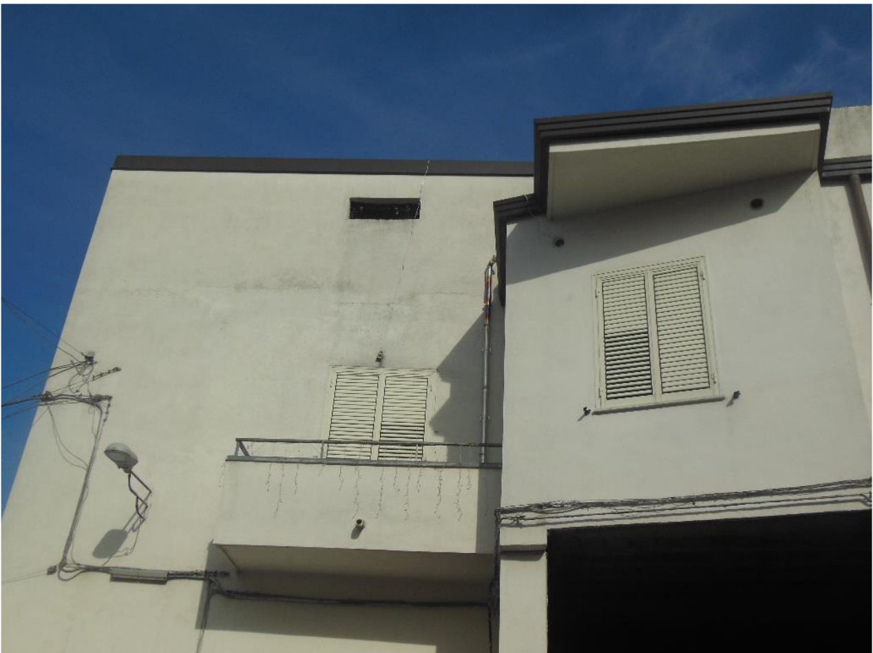
Foto 2 – Vista esterna fabbricato: dettaglio prospetto piano primo
