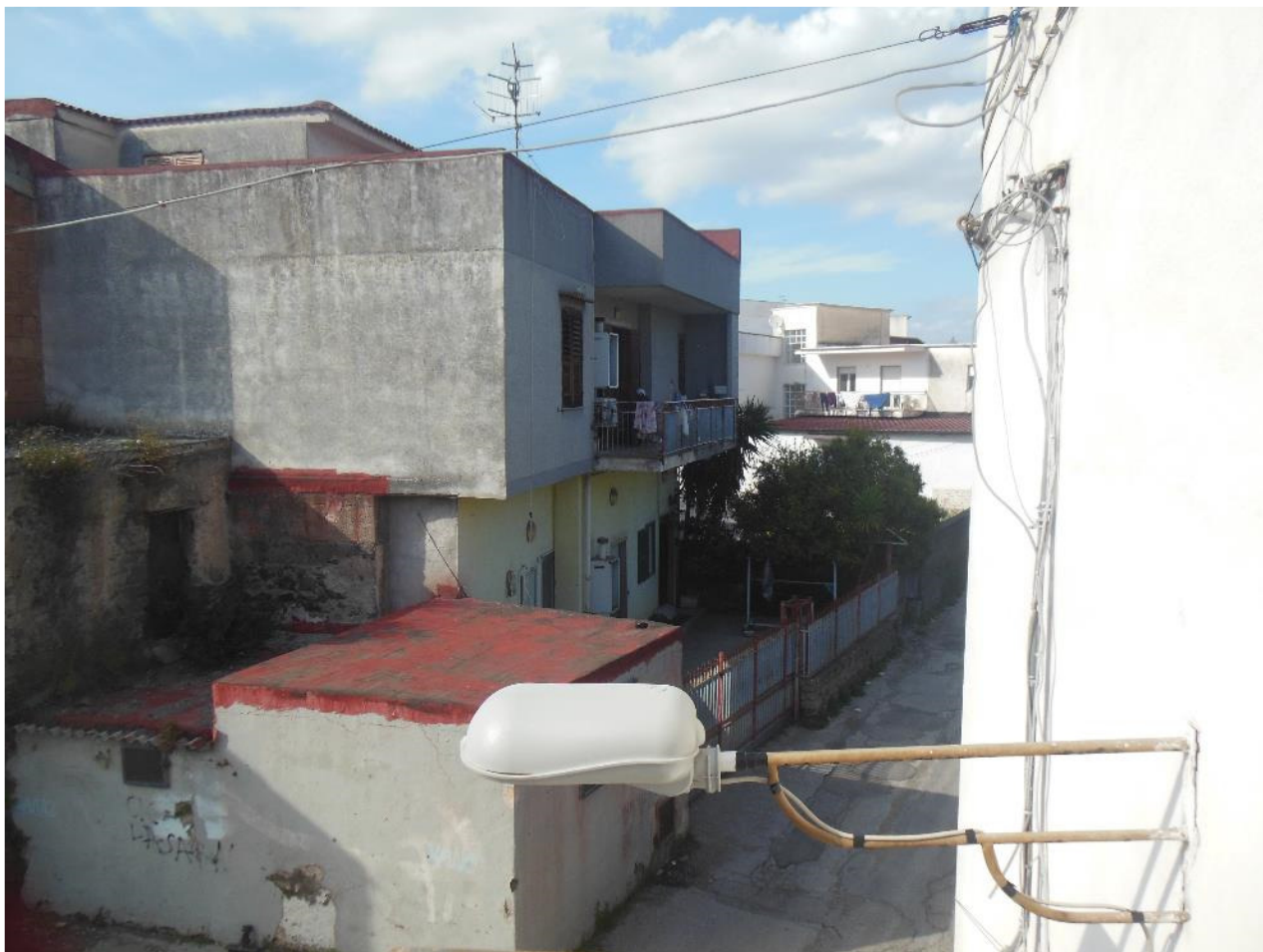
Foto 11 – Vista esterna dal balcone n. 1
