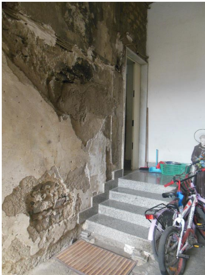
Foto 5 - Vista interna fabbricato: vano con rampa di scale al piano terra
