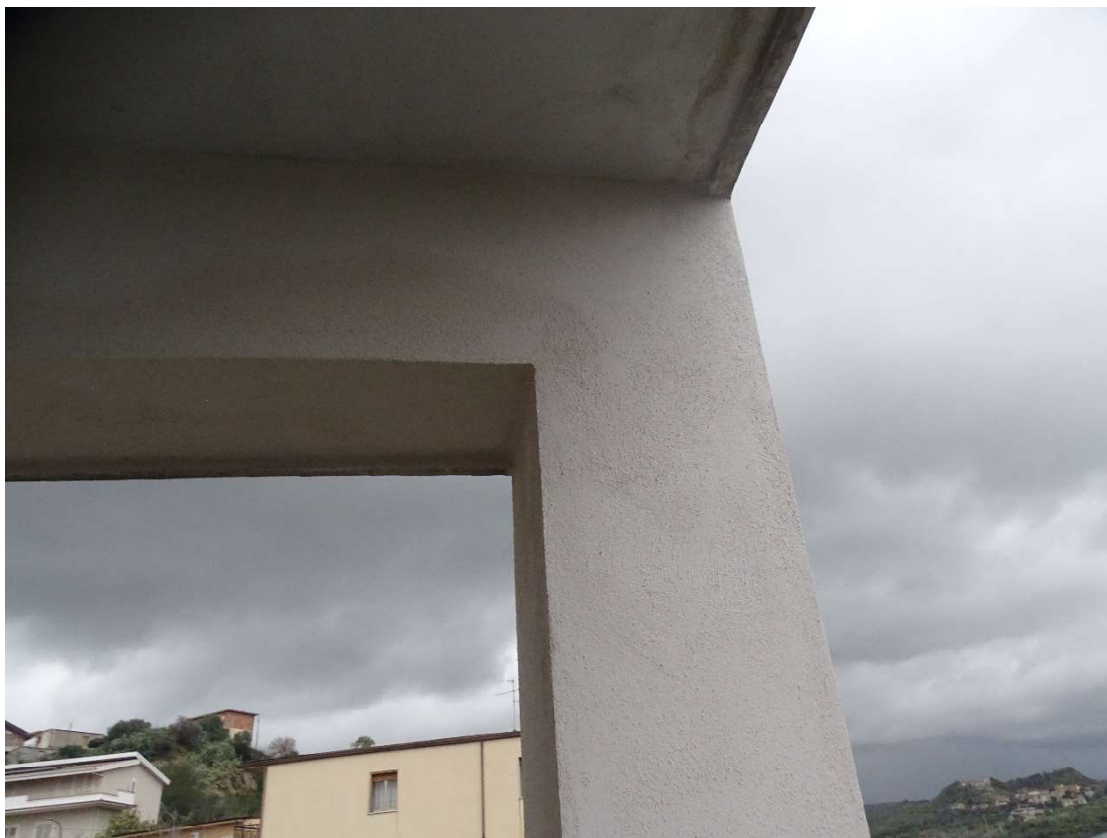
Pilastro d'angolo completato.
