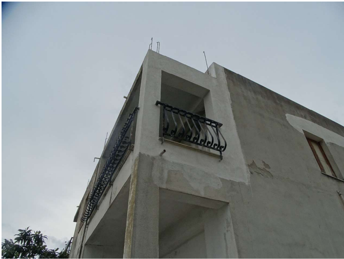
Lato esterno veranda lato sud-ovest completata.
