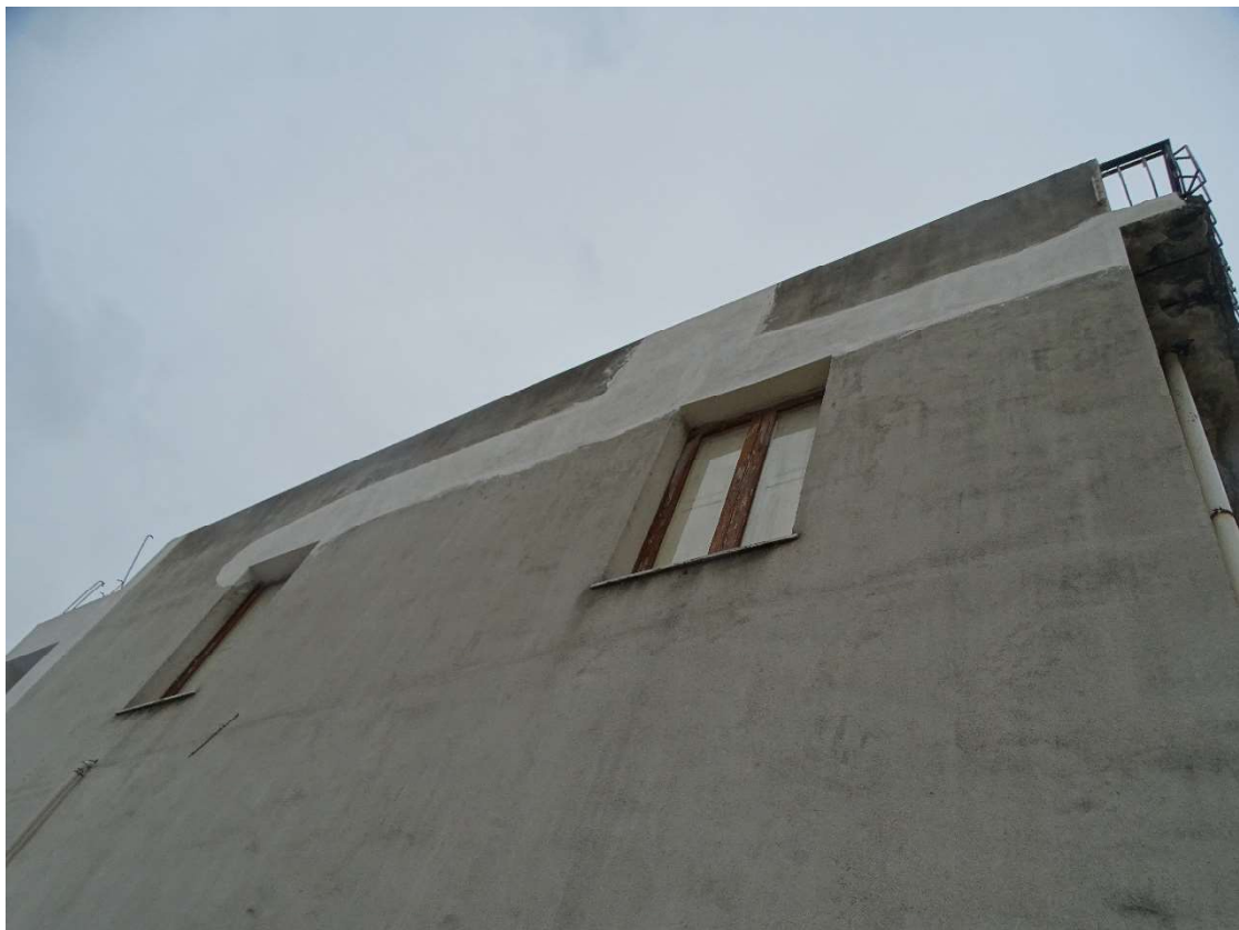
Parete sud-ovest con architravi completati.
