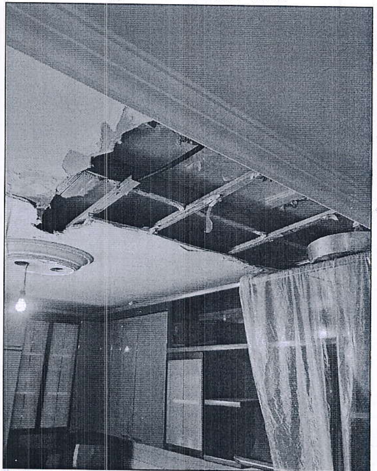
FOTO 11 - tetto cucina - QUARTO PIANO
