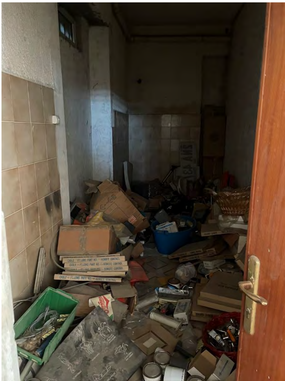
Fotografia n. 18 _ Deposito interno al locale commerciale
