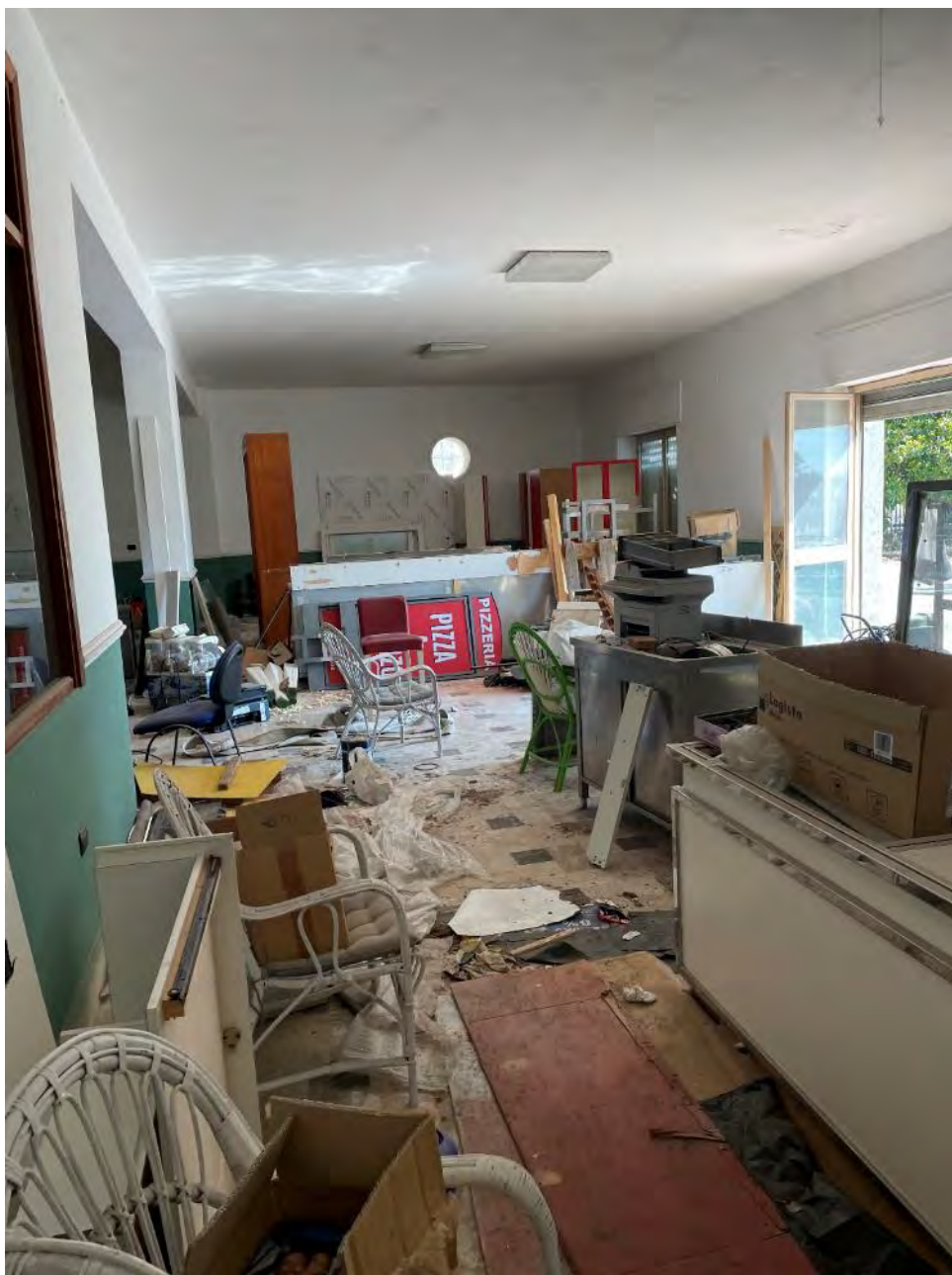
Fotografia n. 13 _ Interno del locale commerciale – zona anteriore
