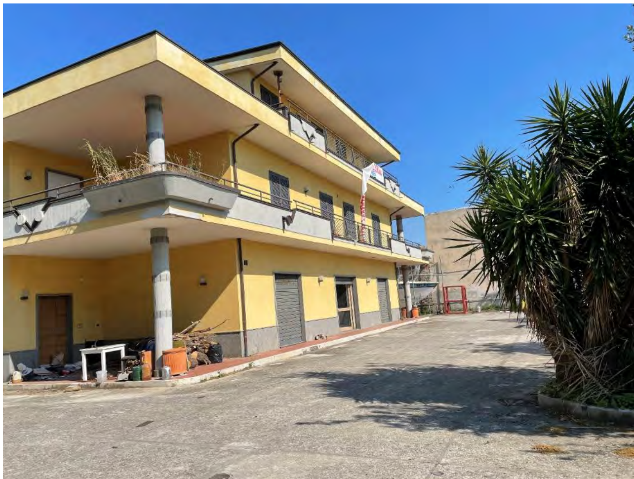
Fotografia n. 1 _ Prospetto ovest Vista nord/sud
