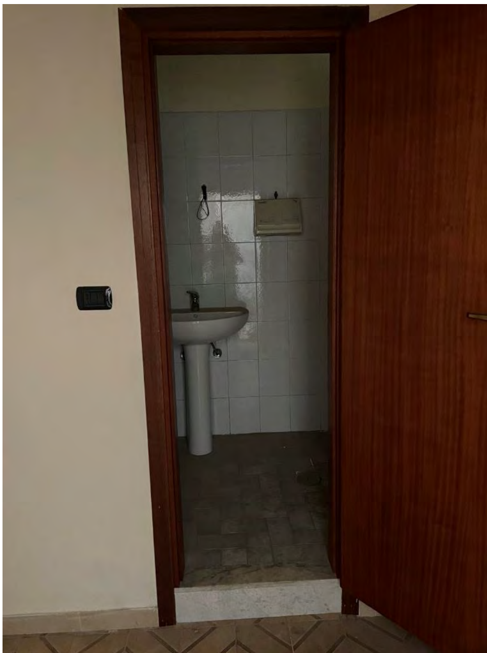
Fotografia n. 19 _ wc interno al locale commerciale
