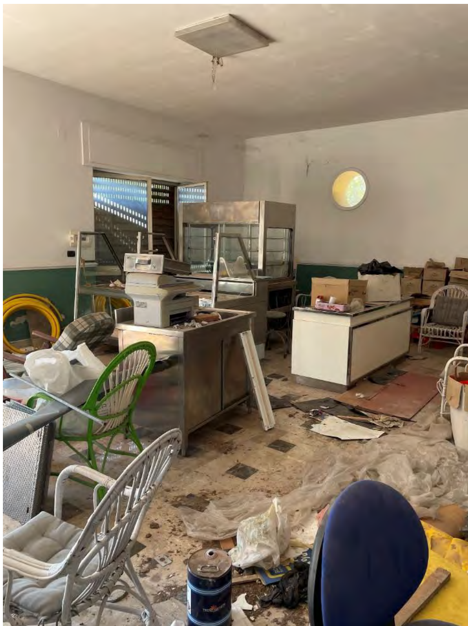
Fotografia n. 14 _ Interno del locale commerciale – zona anteriore
