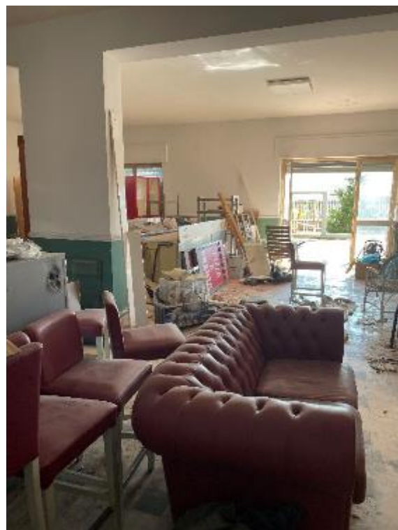
Fotografia n. 12 _ Interno del locale commerciale
