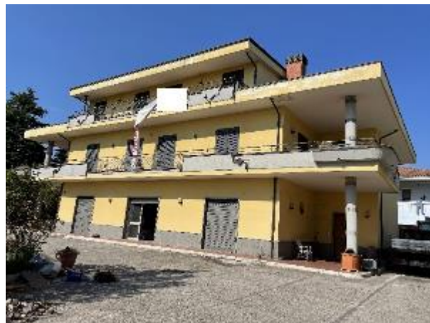
Fotografia n. 2 _ Prospetto ovest Vista sud/nord
