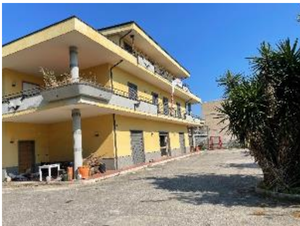
Fotografia n. 1 _ Prospetto ovest Vista nord/sud
