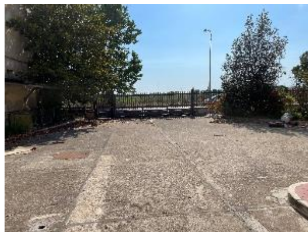
Fotografia n. 8 _ Area scoperta comune all'intero fabbricato
