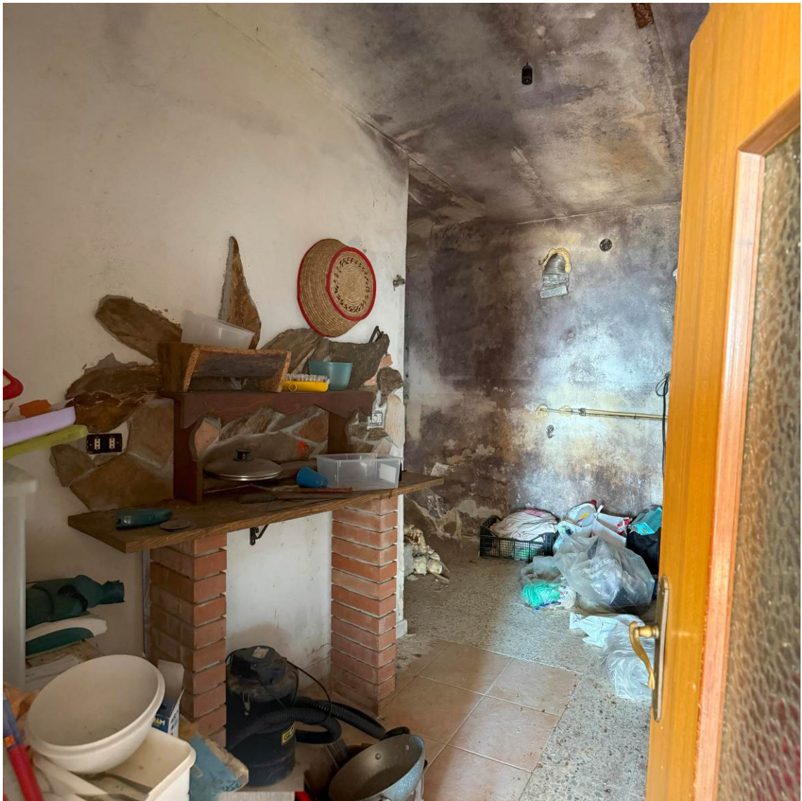
→ Foto 4, piano terra – vista interna ripostiglio
