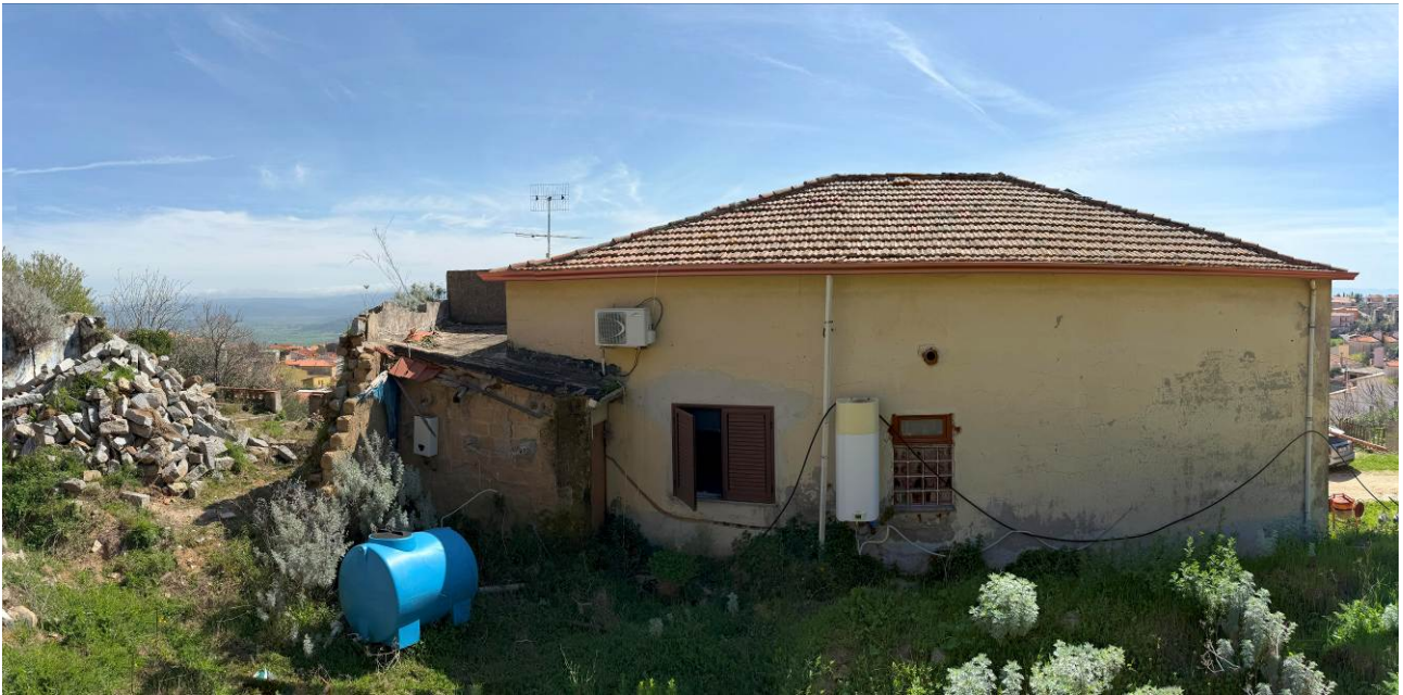
↪ Foto 3, vista esterna immobile, dalla via Papa Giovanni XXIII
