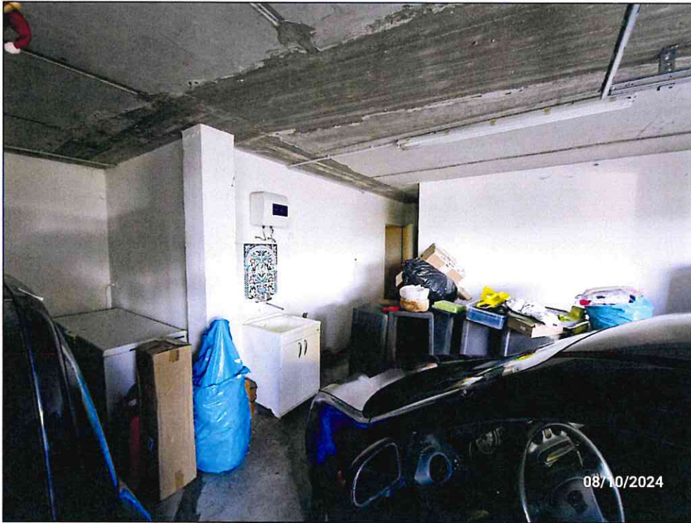
Foto 46: autorimessa – accesso su vano scale condominiale (sub 34 – B.C.N.C. - scale)
