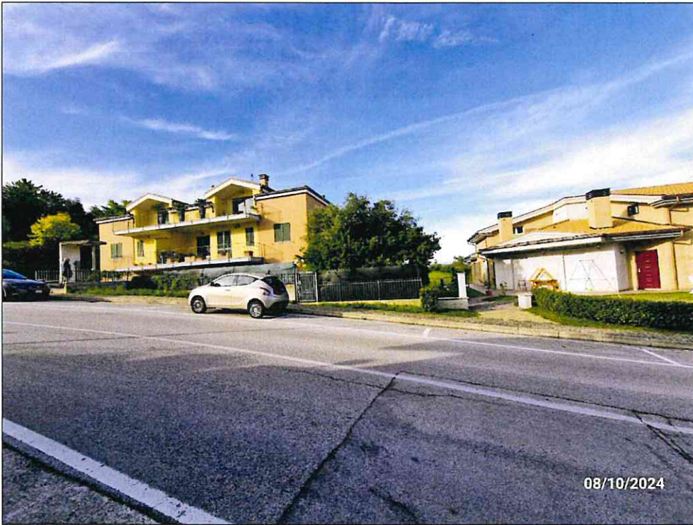
Foto 6: prospetto principale – lato est
