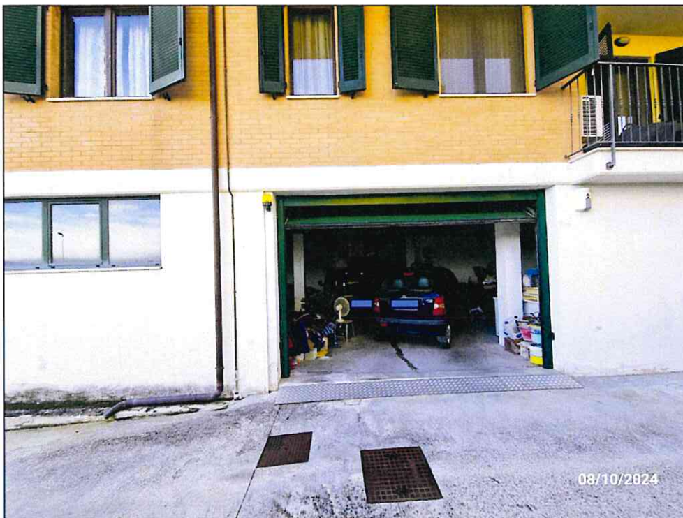
Foto 44: accesso esclusivo ad autorimessa
