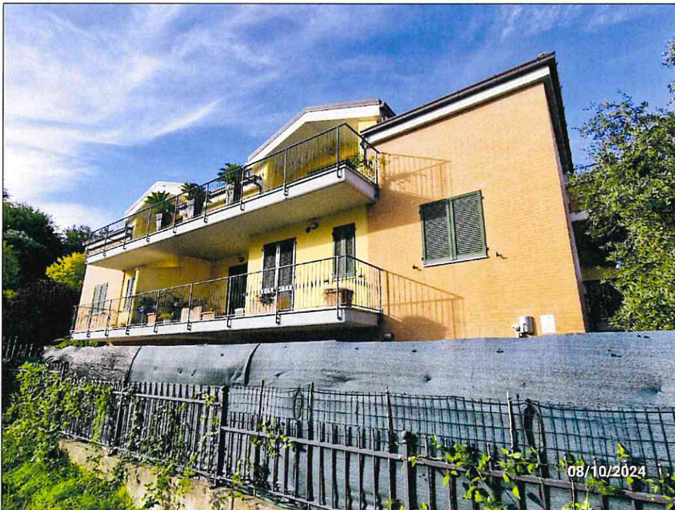
Foto 7: prospetto principale – lato est
