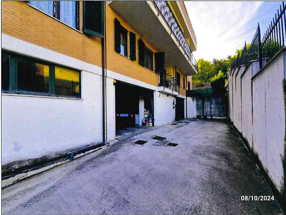
Foto 12: corsia scoperta di accesso ad autorimesse (sub 21 – B.C.N.C. - corte)
