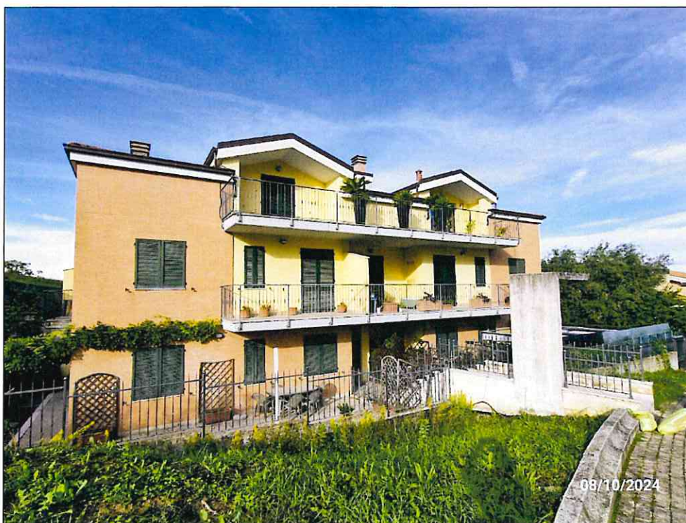
Foto 5: prospetto principale – lato est
