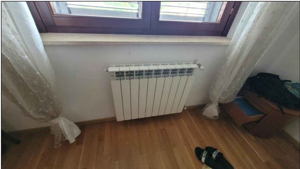
Foto 13: particolare pavimento in parquet, radiatori e infissi
