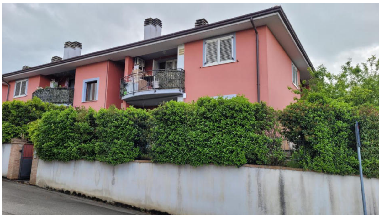
Foto 5: vista lato ingresso pedonale
