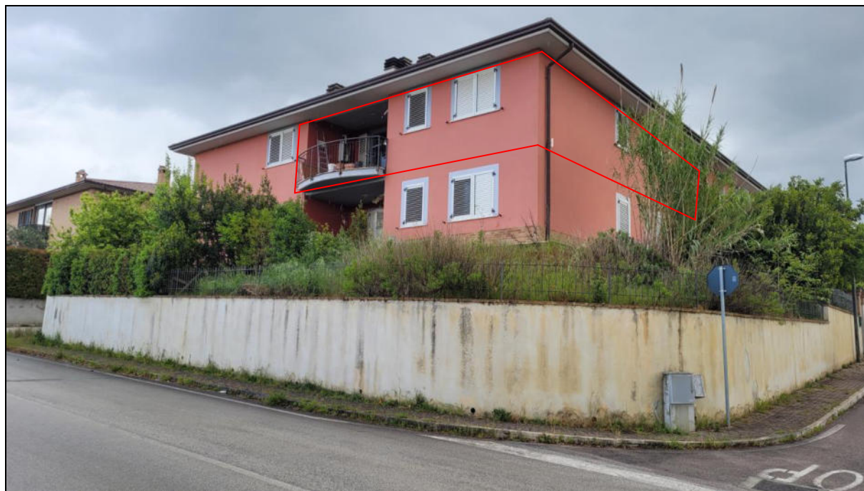
Foto 1: vista fabbricato vocabolo San Rocco Basso
