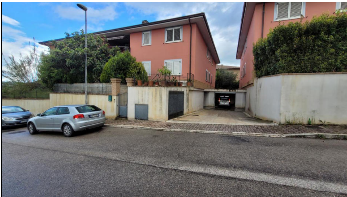
Foto 4: vista ingresso rampa condominiale
