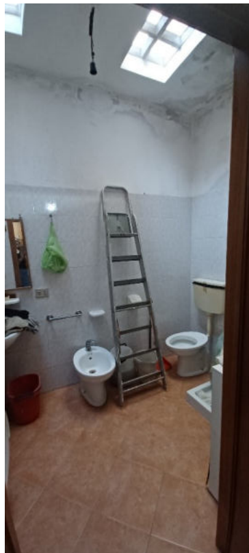
FOTO 14 - BAGNO PIANO TERRA E LUCERNAI
