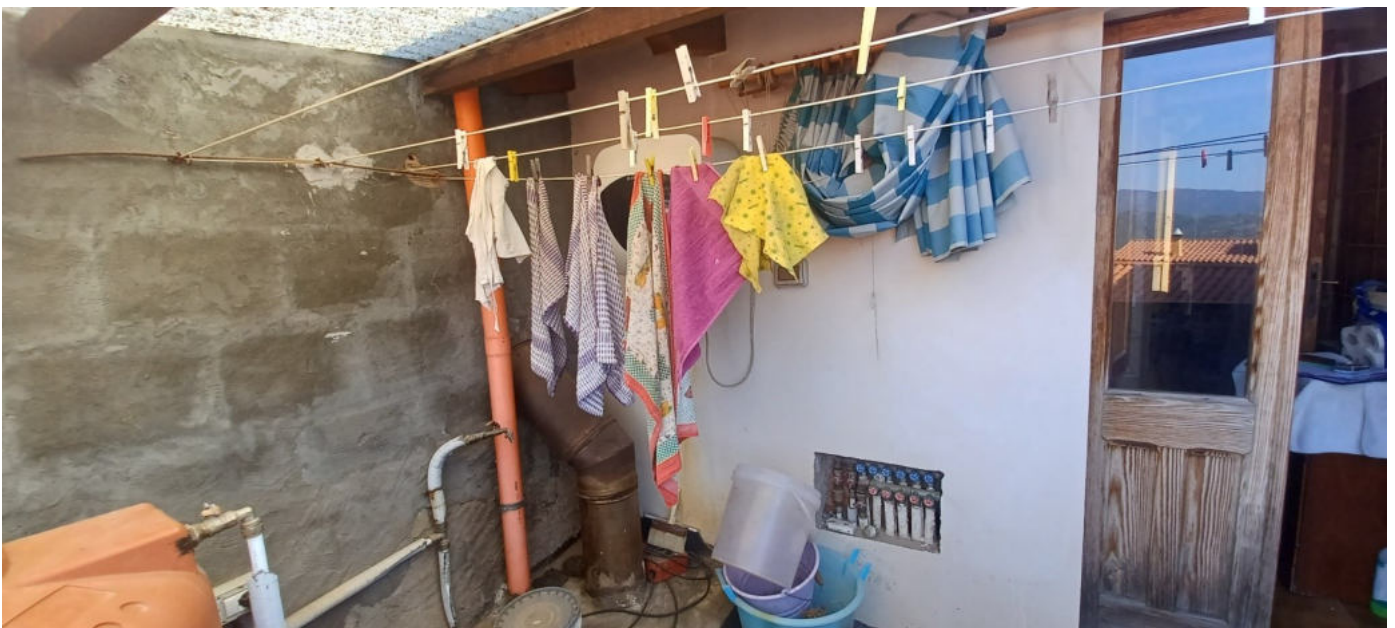
FOTO 28 - TERRAZZO PIANO PRIMO
