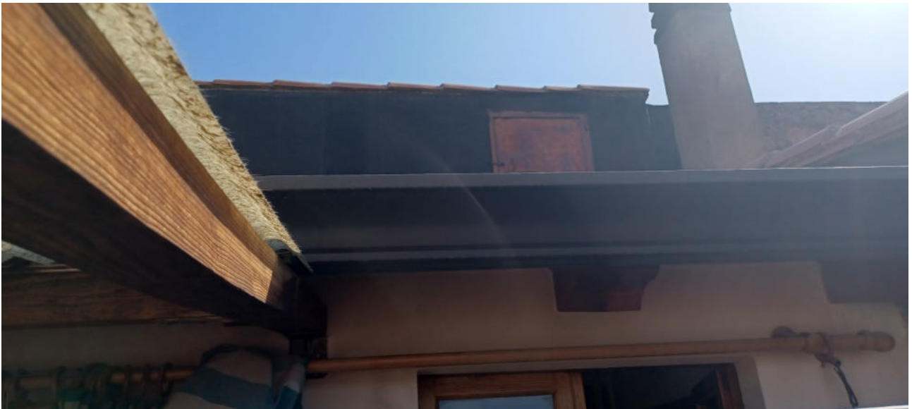
FOTO 26 – DETTAGLIO COPERTURA VISTA DAL TERRAZZO
