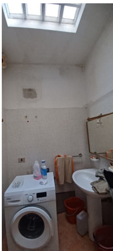
FOTO 15 - BAGNO PIANO TERRA
