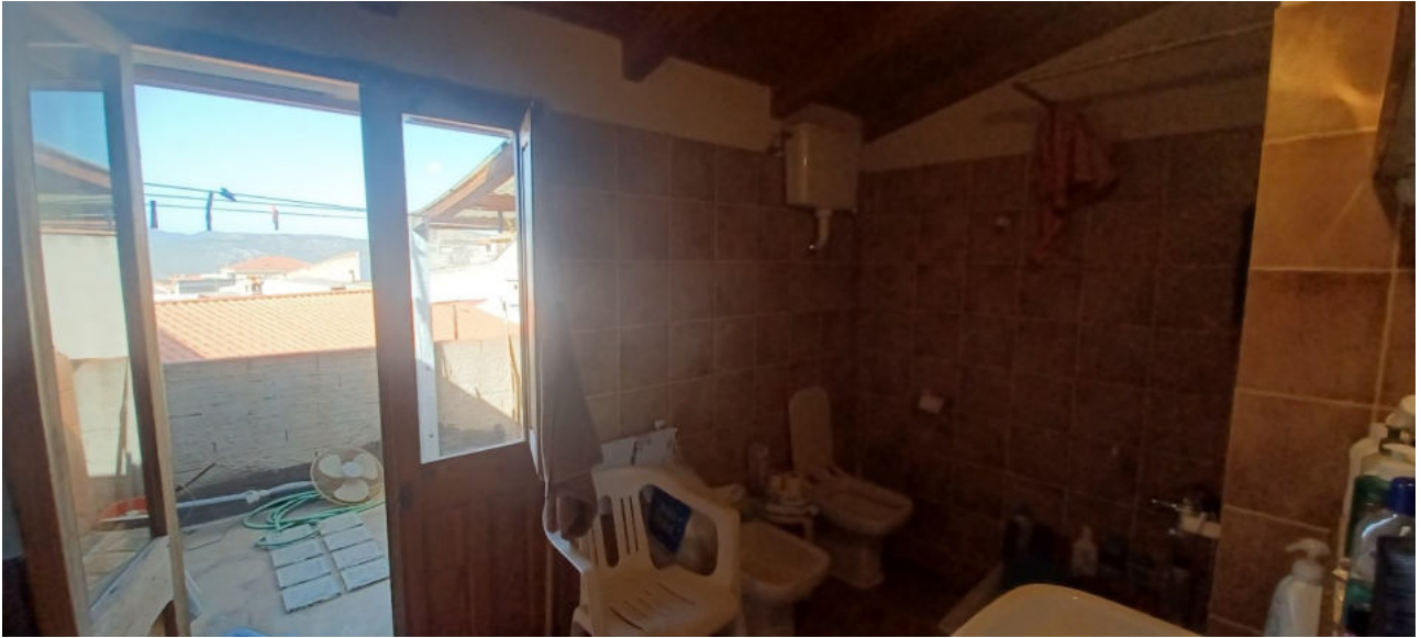
FOTO 25 – BAGNO PIANO PRIMO
