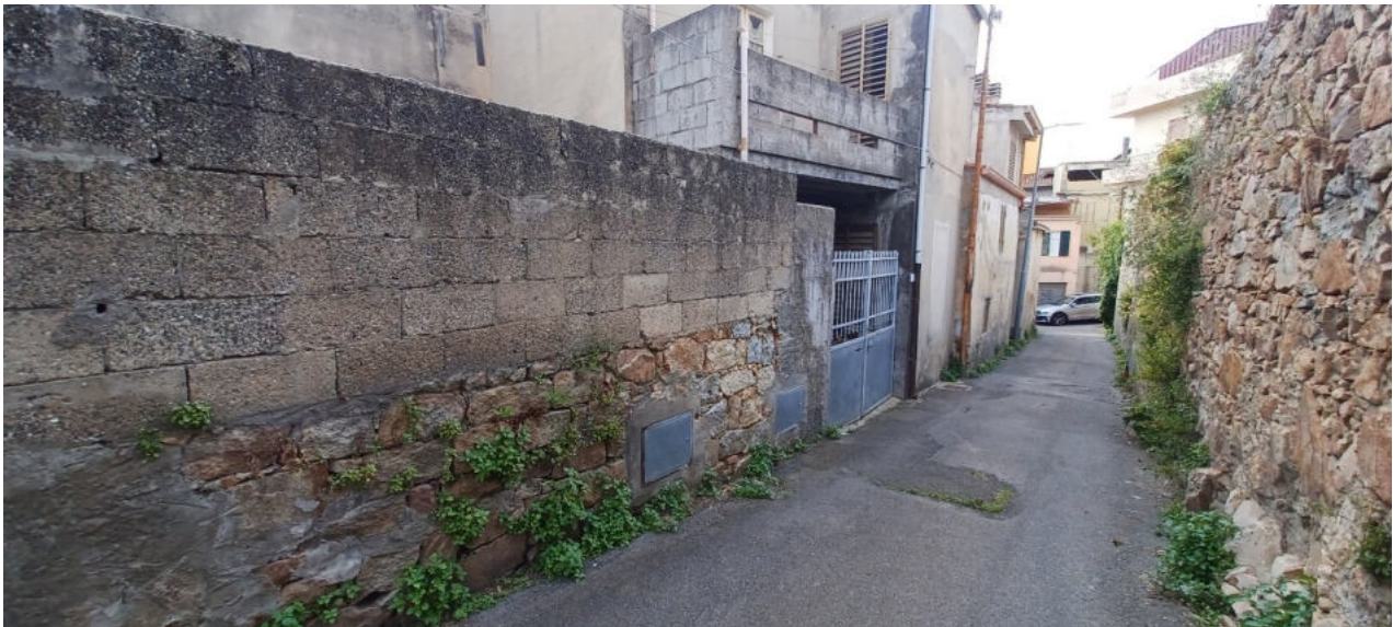
FOTO 04 - VISTA EDIFICIO DA SUD-EST
