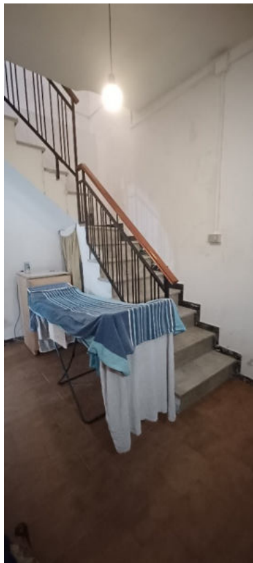
FOTO 10 - SCALE DAL DISIMPEGNO
