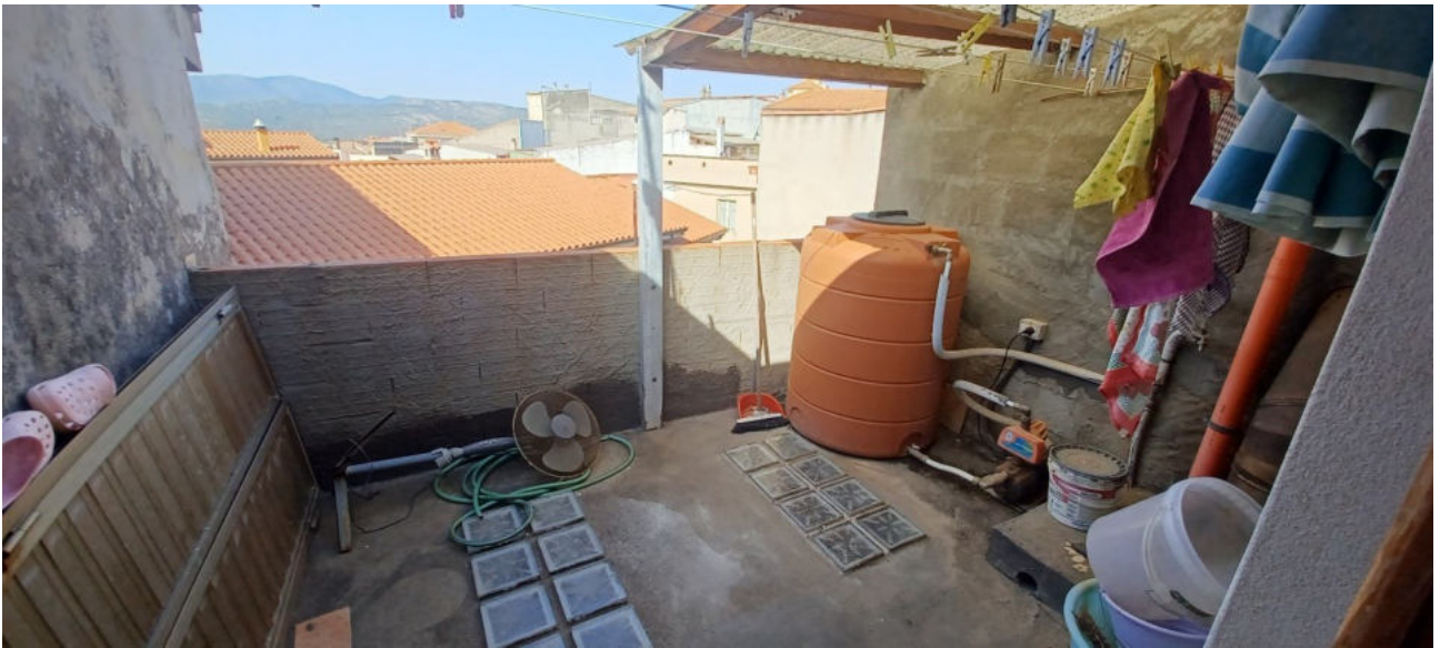
FOTO 27- TERRAZZO PIANO PRIMO
