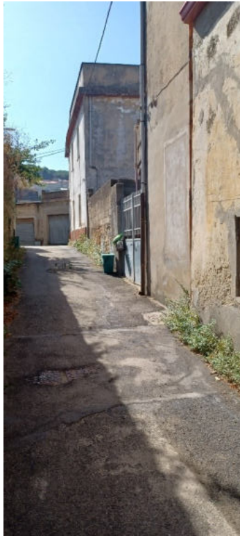
FOTO 05 - VISTA EDIFICIO DA NORD-OVEST
