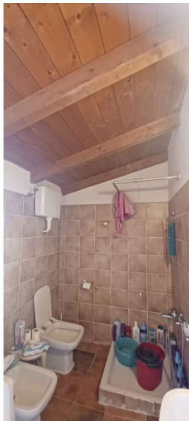
FOTO 24 – BAGNO PIANO PRIMO
