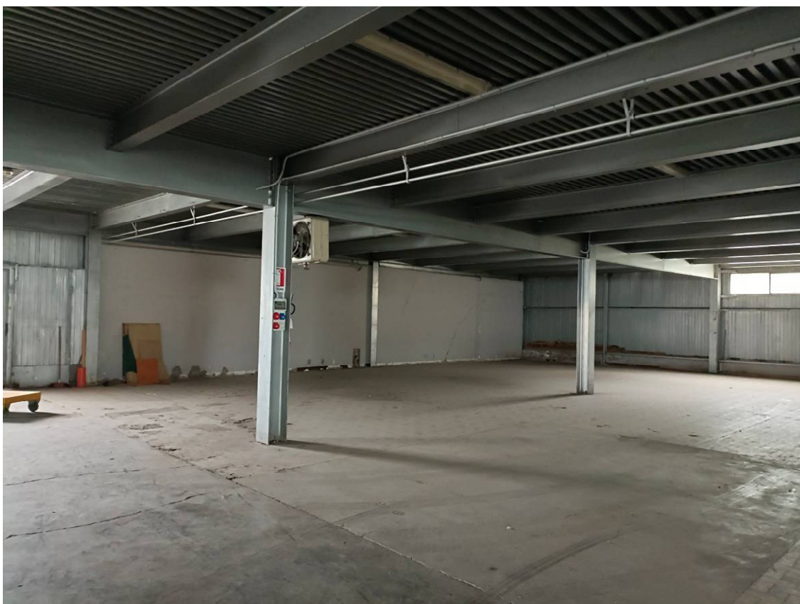
Foto n. 14 – Vista generale interni
