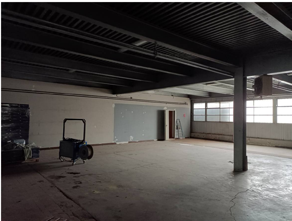
Foto n. 13 – Vista generale interni
