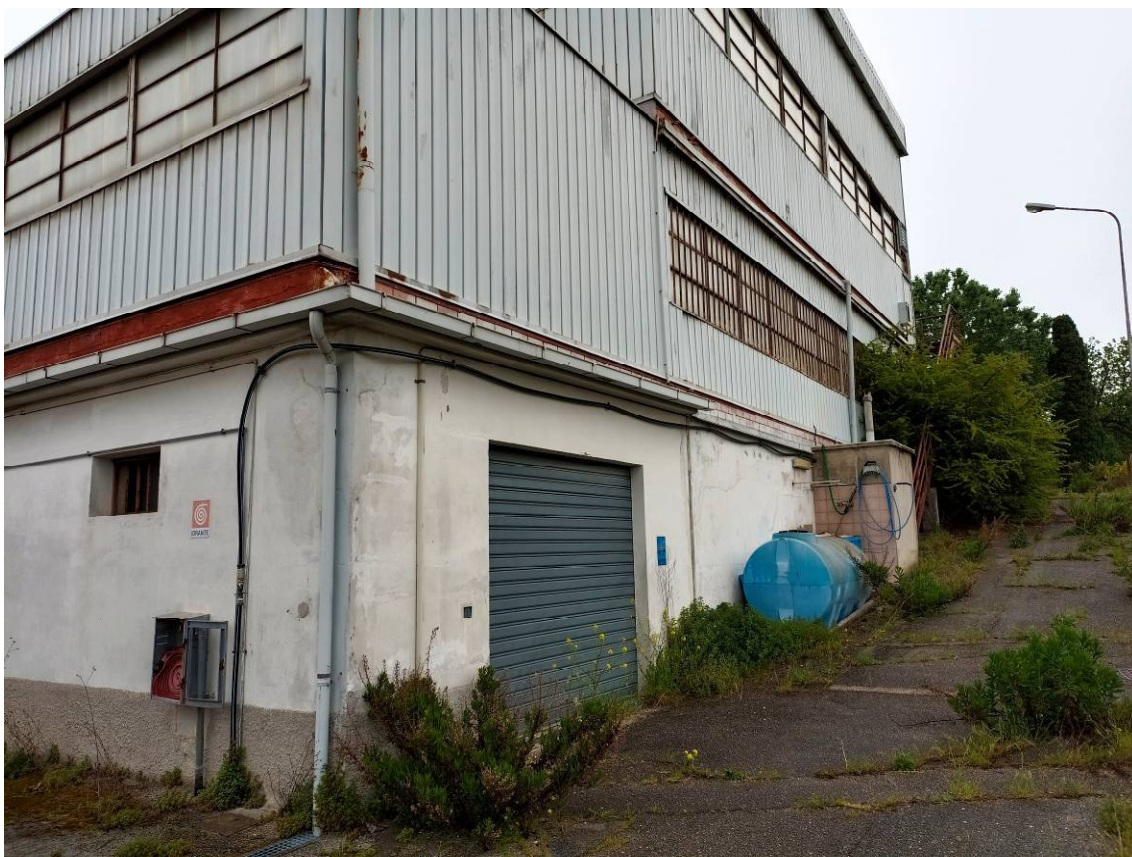
Foto n. 3 – Vista generale Prospetto Nord-Ovest
