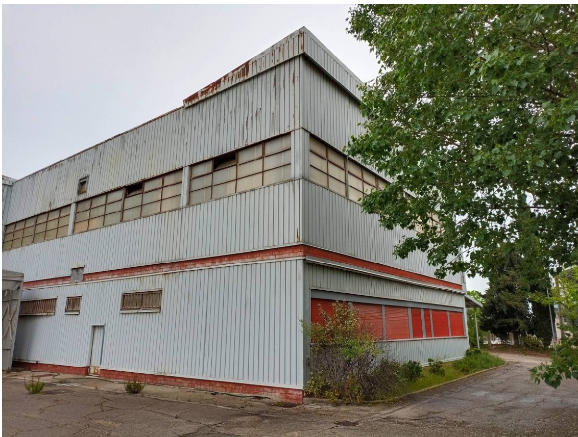
Foto n. 1 – Vista generale Prospetto Sud-Ovest
