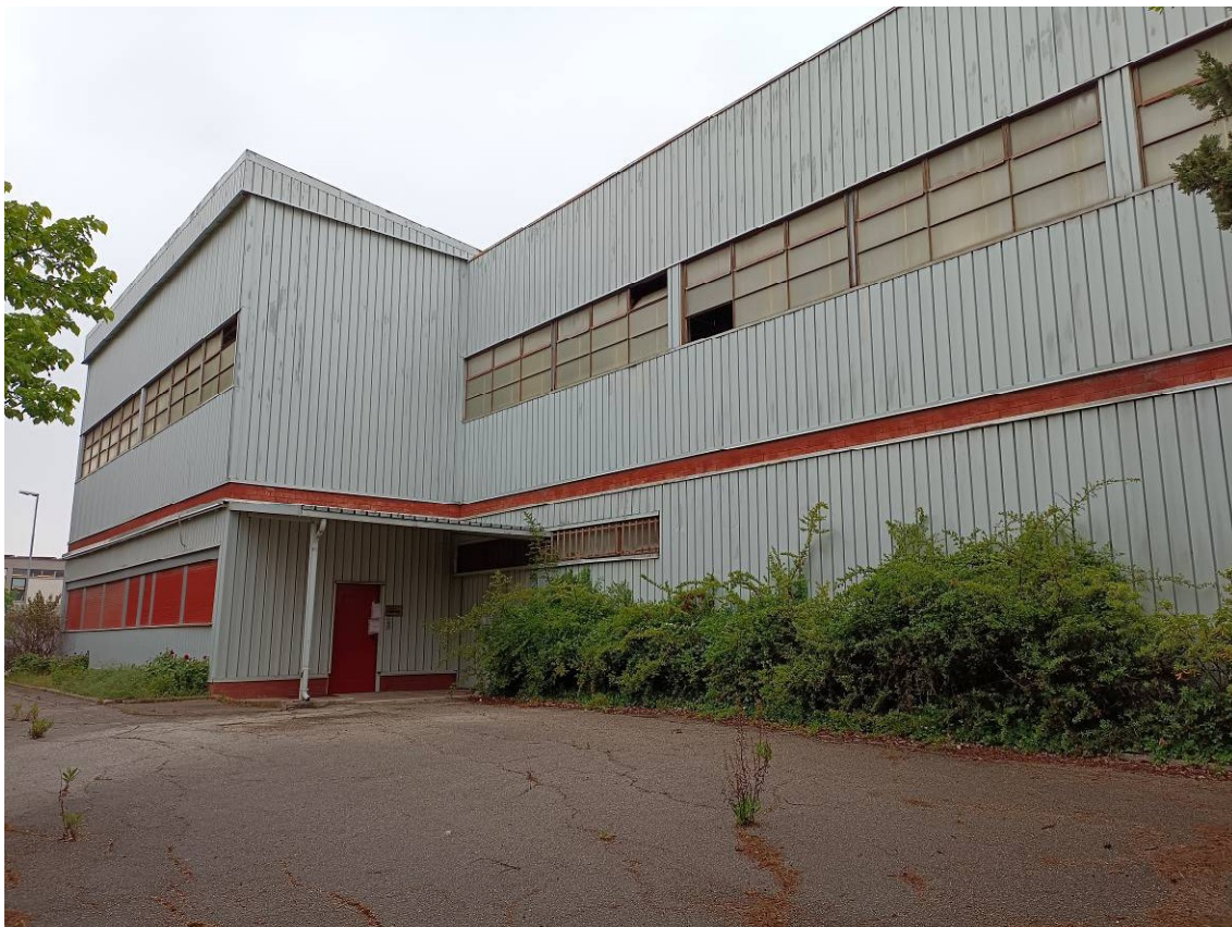
Foto n. 8 – Vista generale Prospetto Sud
