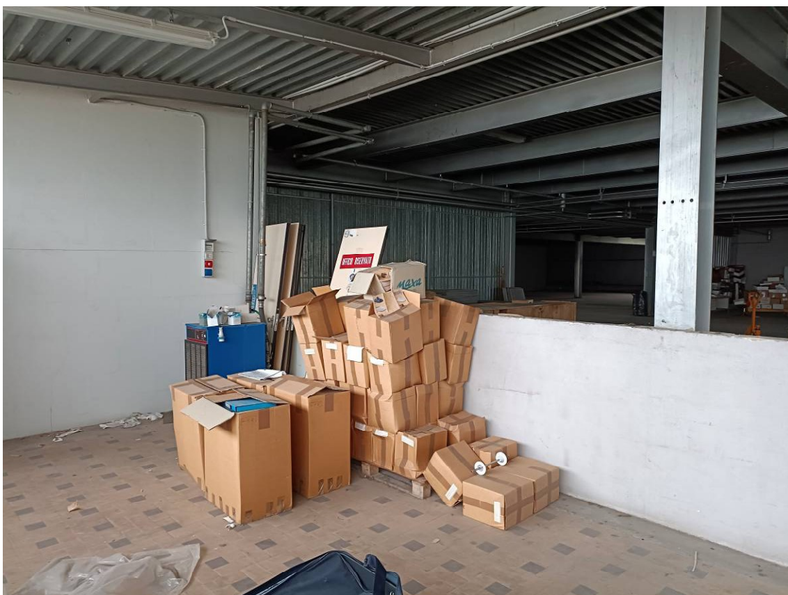
Foto n. 18 – Vista generale interni
