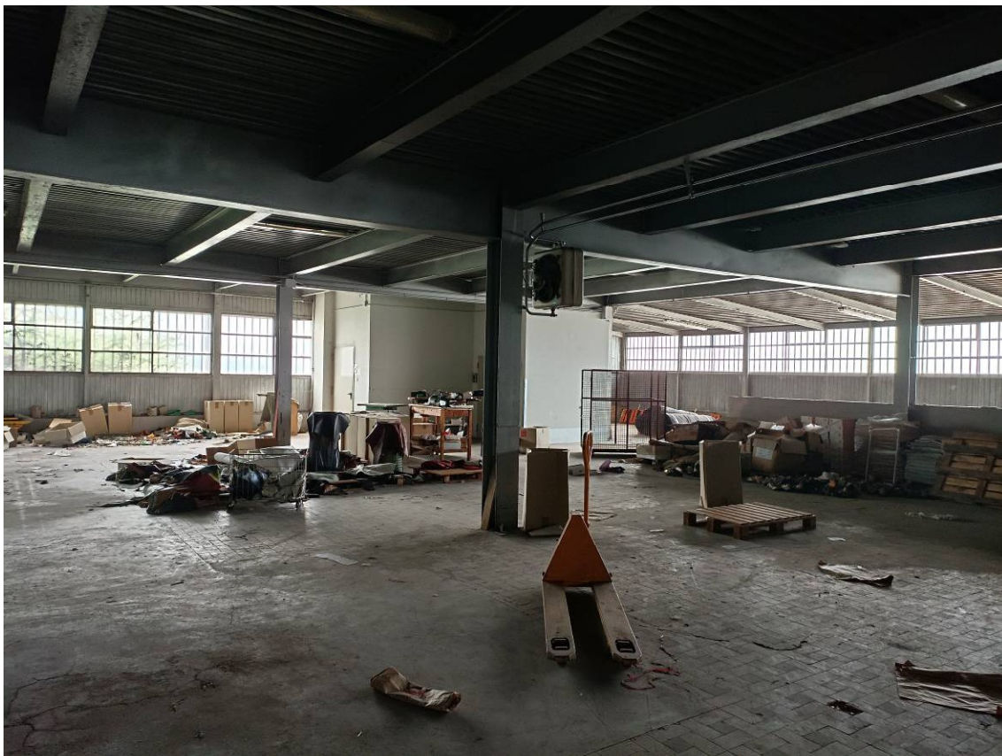
Foto n. 16 – Vista generale interni
