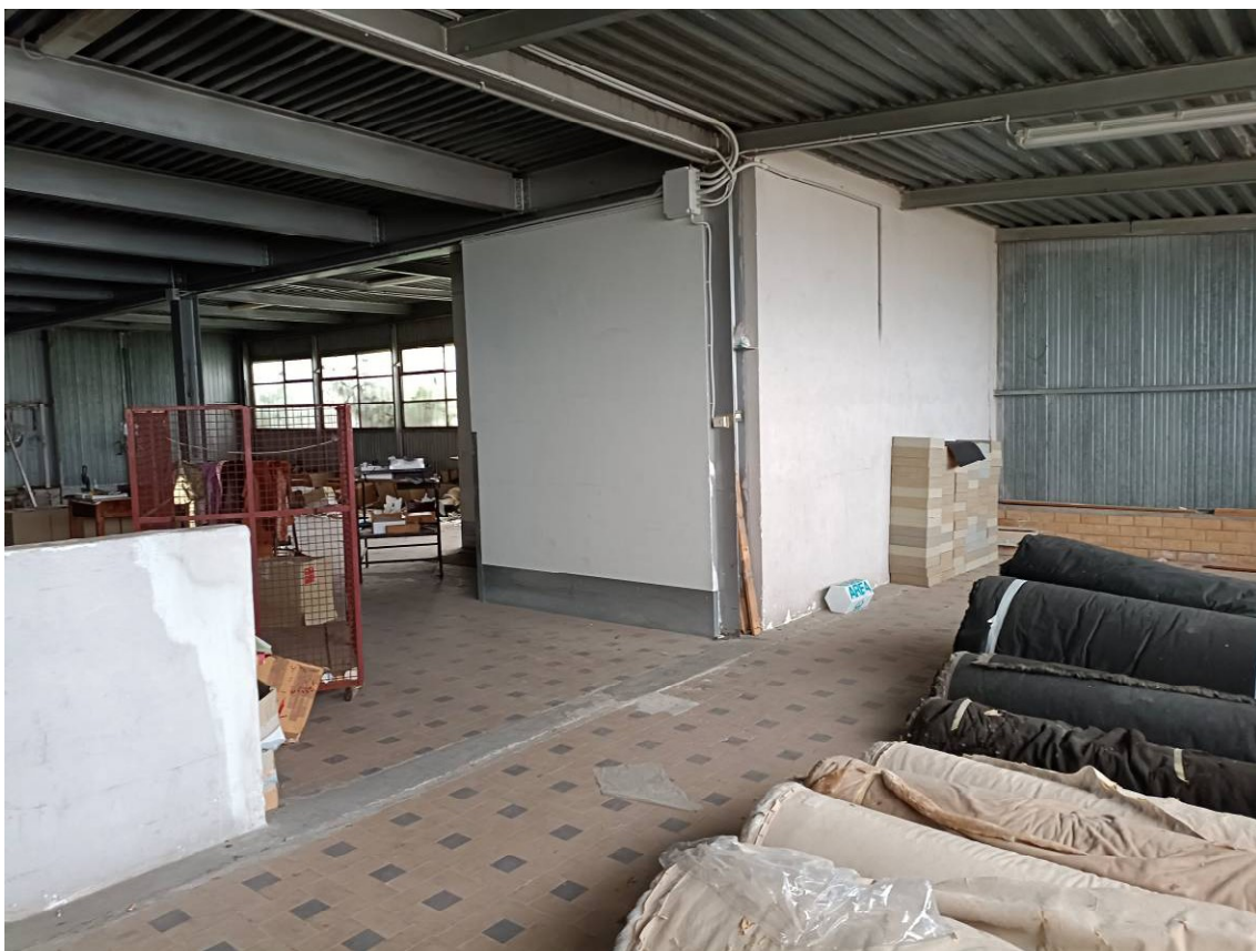
Foto n. 17 – Vista generale interni
