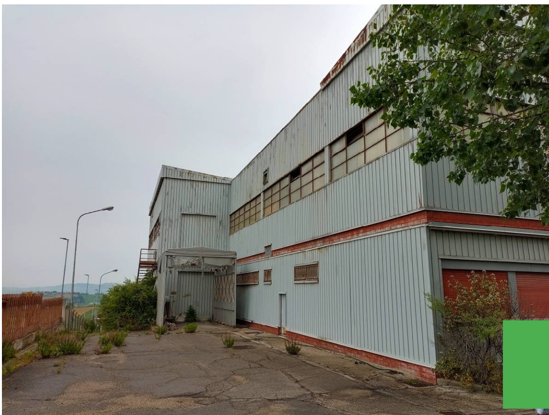
Foto n. 2 – Vista generale Prospetto Ovest
