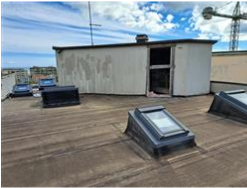
05.LOCALE ACCESSORIO P.5 (SOPPALCO) - SUB_14
