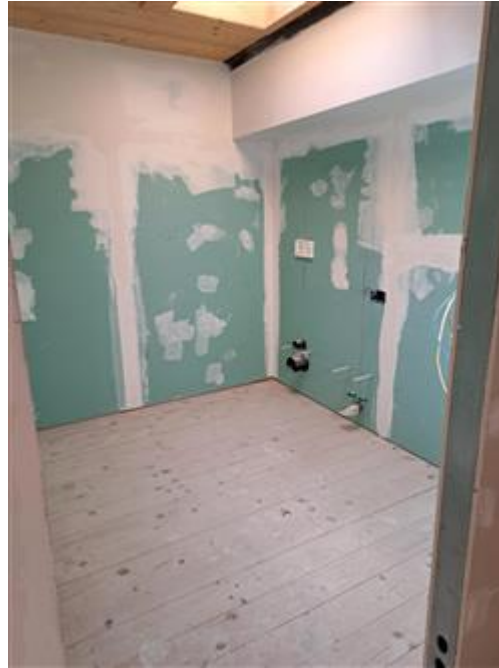
04.INTERNO P.4 (SOPPALCO) - SUB_14
