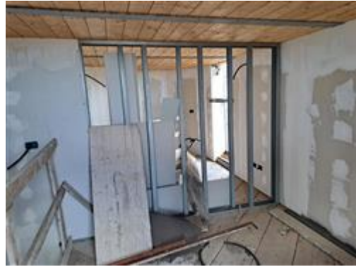
06.INTERNO LOCALE ACCESSORIO P.5 - SUB_15
