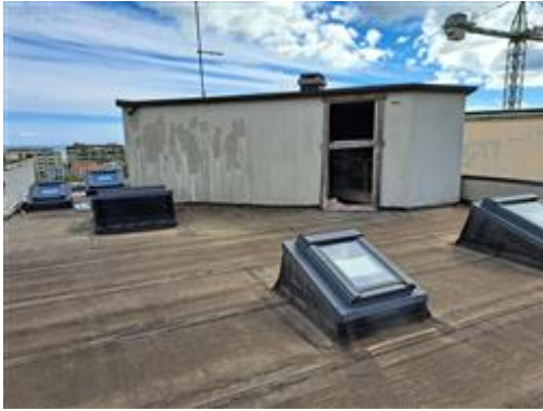
05.INGRESSO ESTERNO LOCALE ACCESSORIO P.5 (SOPPALCO) - SUB_15
