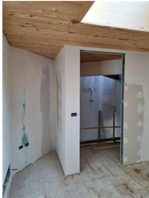
04.INTERNO P.4 (SOPPALCO) - SUB_15
