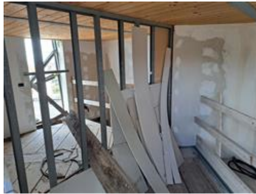
06.INTERNO LOCALE ACCESSORIO P.5 - SUB_14
