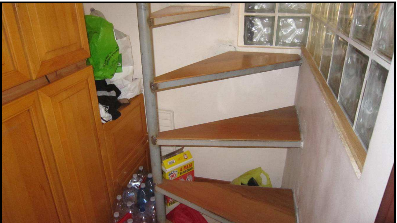
Foto 20 Abitazione part. 755 sub. 3 – Scala di accesso al sottotetto
