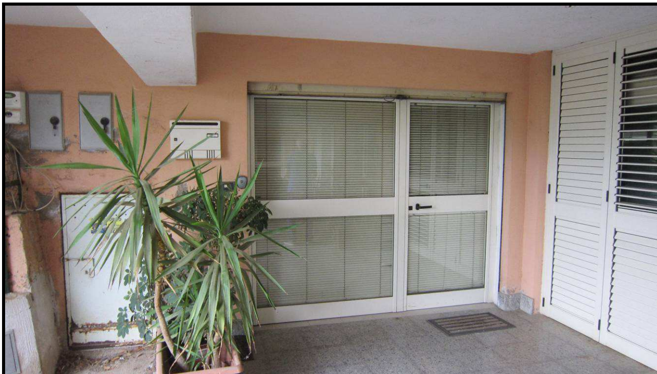
Foto 3 Ingresso ufficio part. 755 sub. 6
