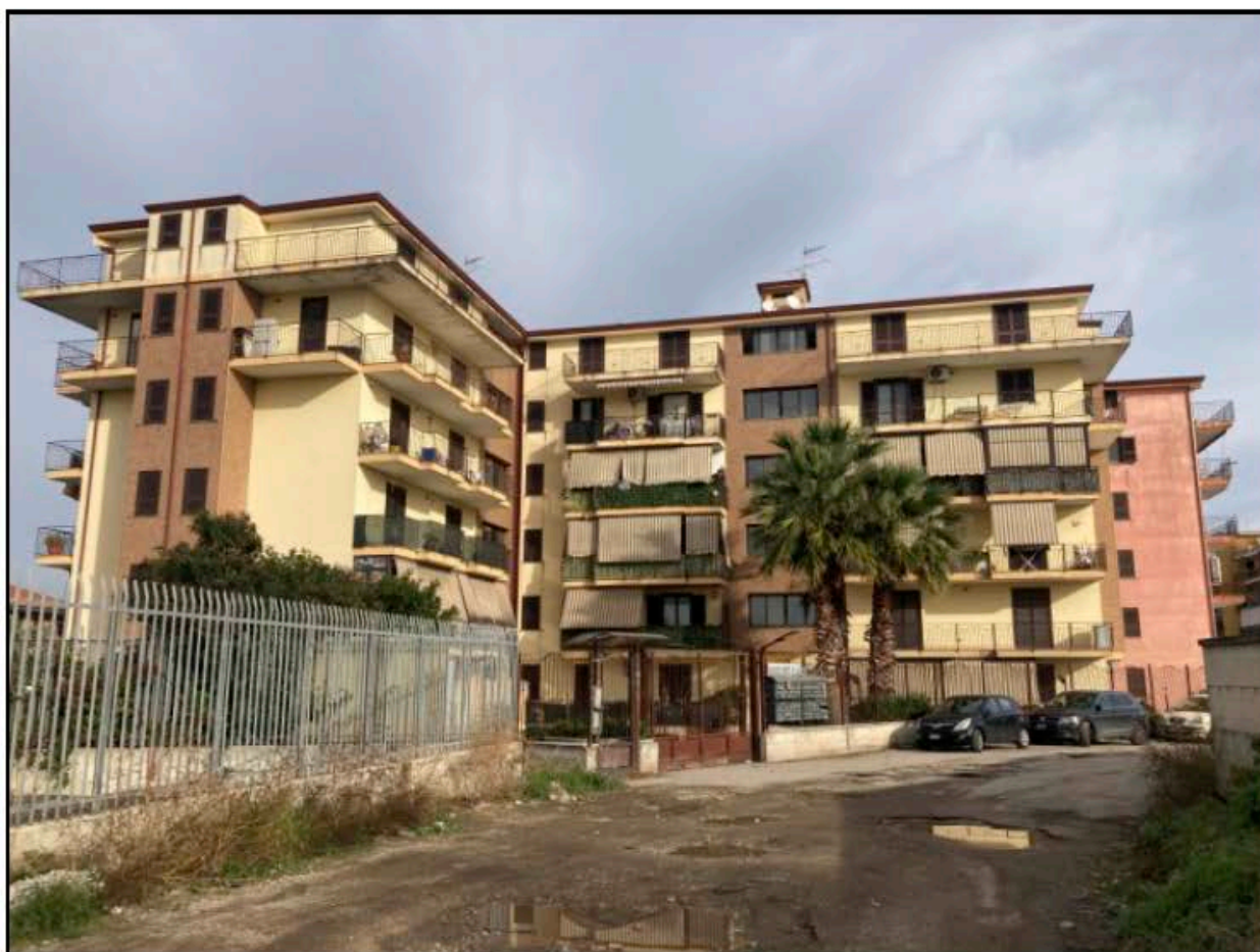
Ingresso carrabile e pedonale del complesso edilizio "Parco del lago"
