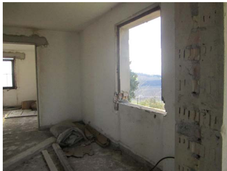
foto n.5 - PIANO TERRA interno
