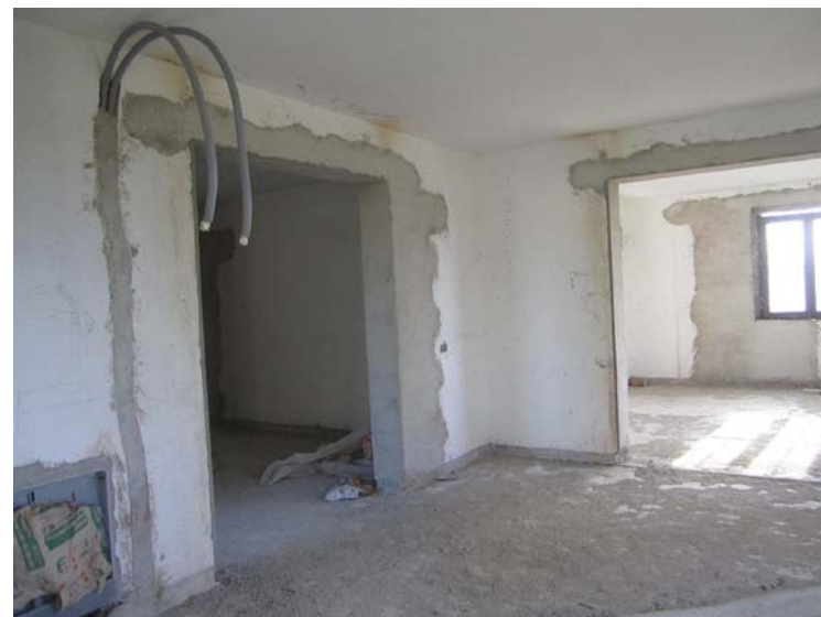
foto n.6 - PIANO TERRA interno
