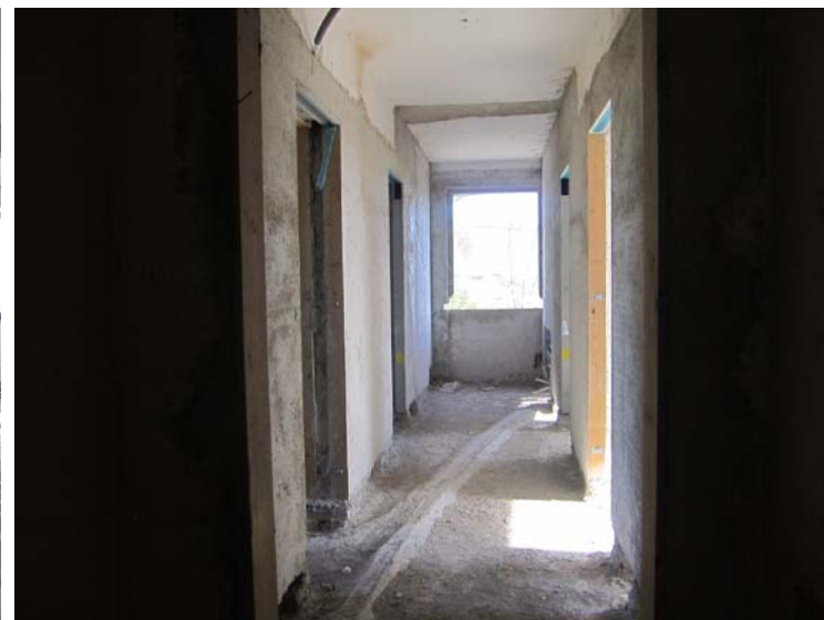
foto n.7 - PIANO TERRA interno
