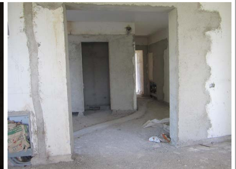
foto n.8 - PIANO TERRA interno
