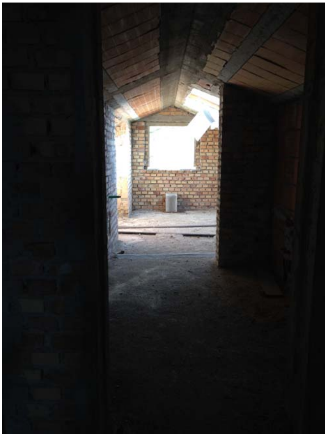
foto n.13 - PIANO I SOTTOTETTO
