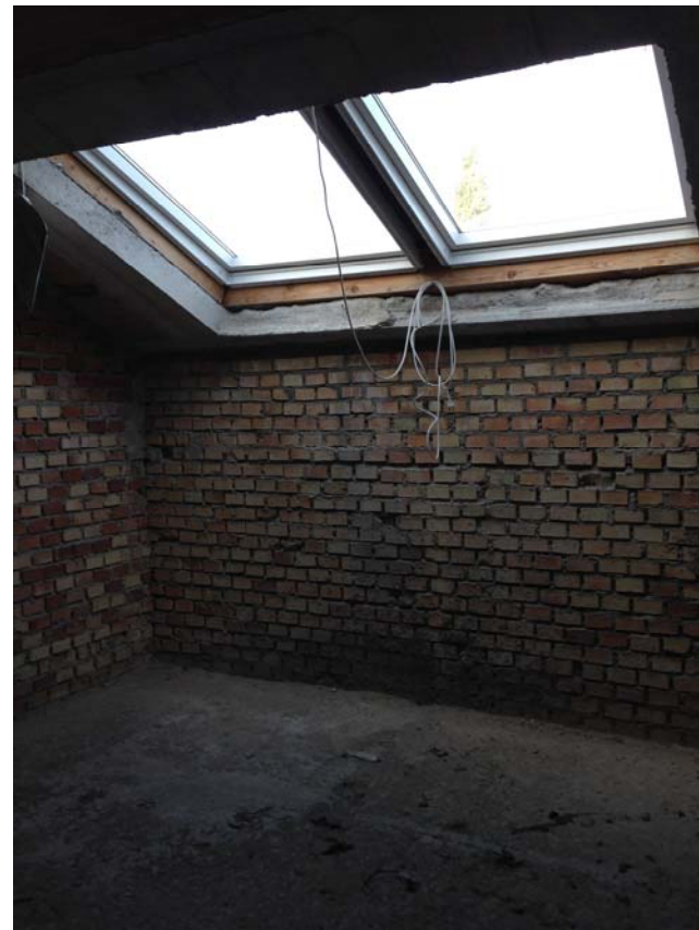
foto n.14 - PIANO I SOTTOTETTO
