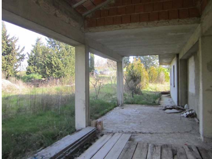
foto n.9 - PIANO TERRA pergola
