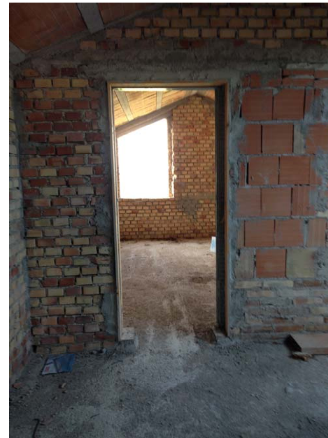
foto n.15 - PIANO I SOTTOTETTO
