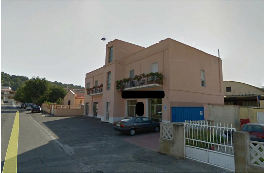
FOTOGRAFIA 46 LOTTO 18-20 PROSPETTO SULLA VIA TREXENTA
