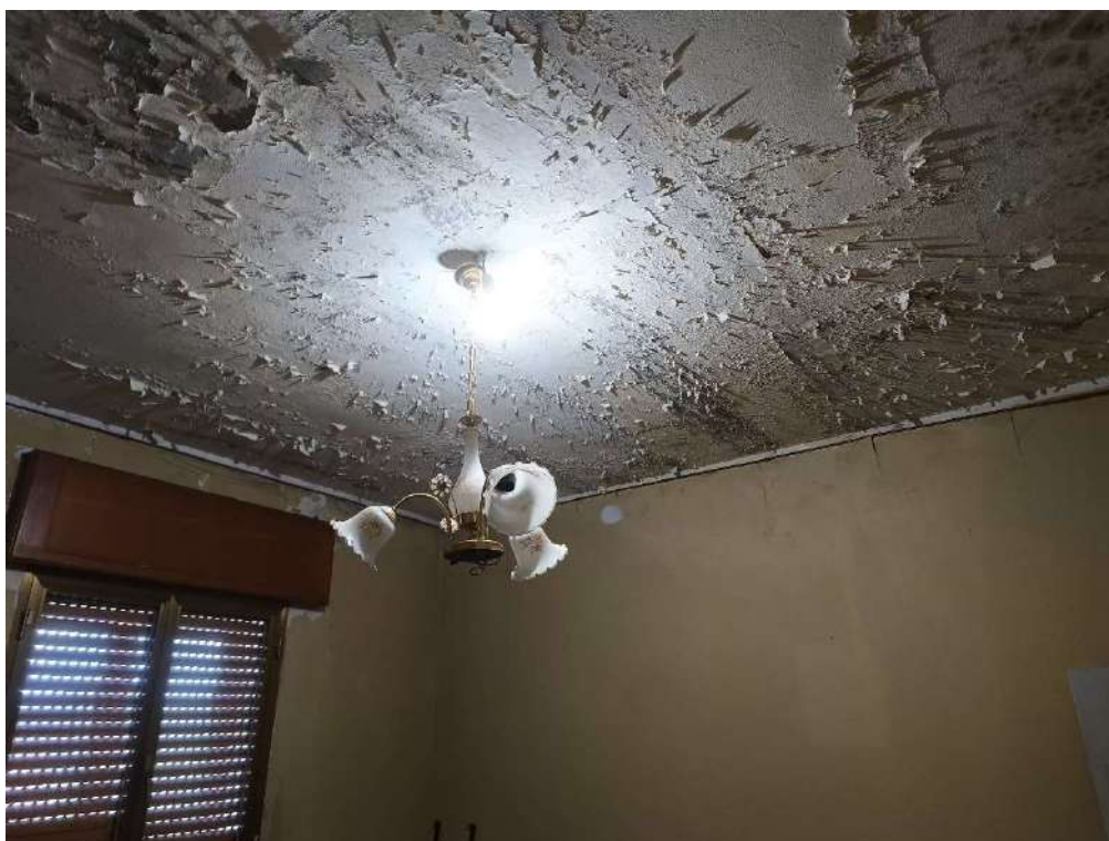
foto n° 10 - Vista interna immobile Lotto 4
