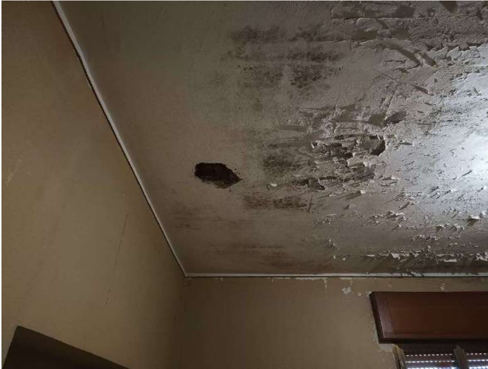
foto n° 7 - Vista interna immobile Lotto 4
