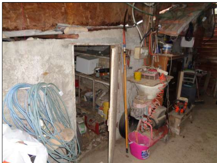
Foto n. 2 – magazzino part. 903 sub 1
