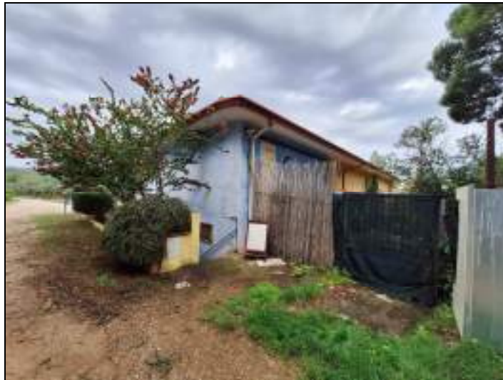
Foto n°5 – Prospetti Laterale Dx-Posteriore - P.T.
