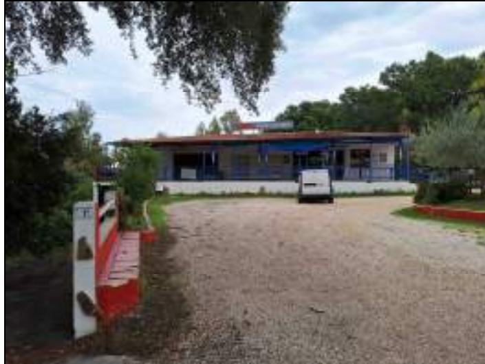
Foto n°1 – Prospetto Anteriore - P.T..
