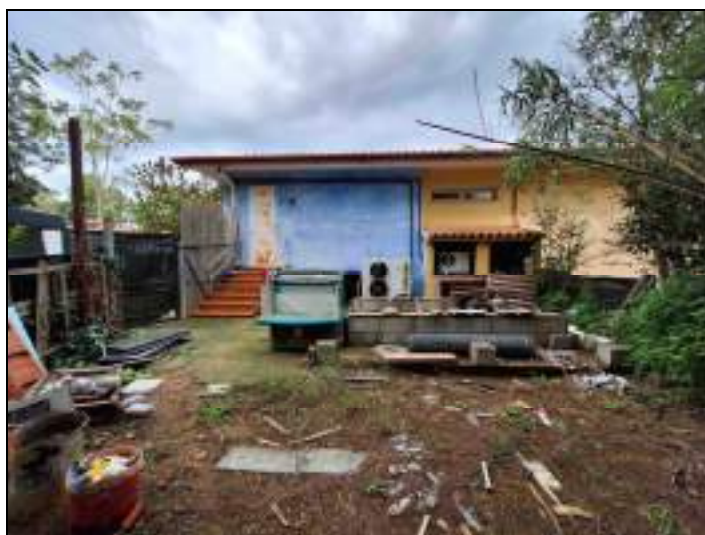
Foto n°8 - Prospetto Posteriore - P.T..
