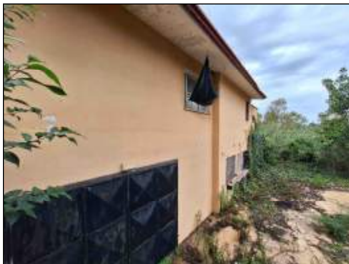
Foto n°7- Prospetto Posteriore - P.T..
