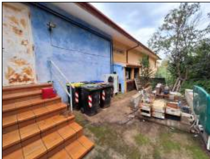
Foto n°6 – Prospetto Posteriore - P.T.
