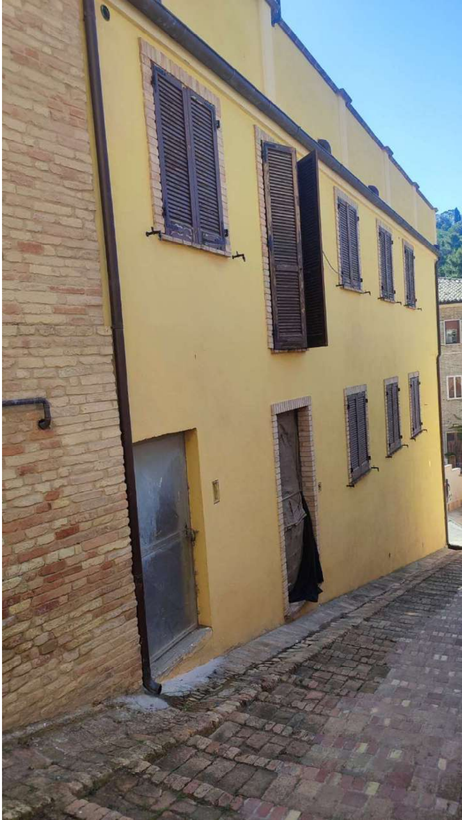
Accesso al piano sottostrada 1 da Porta Cannella
