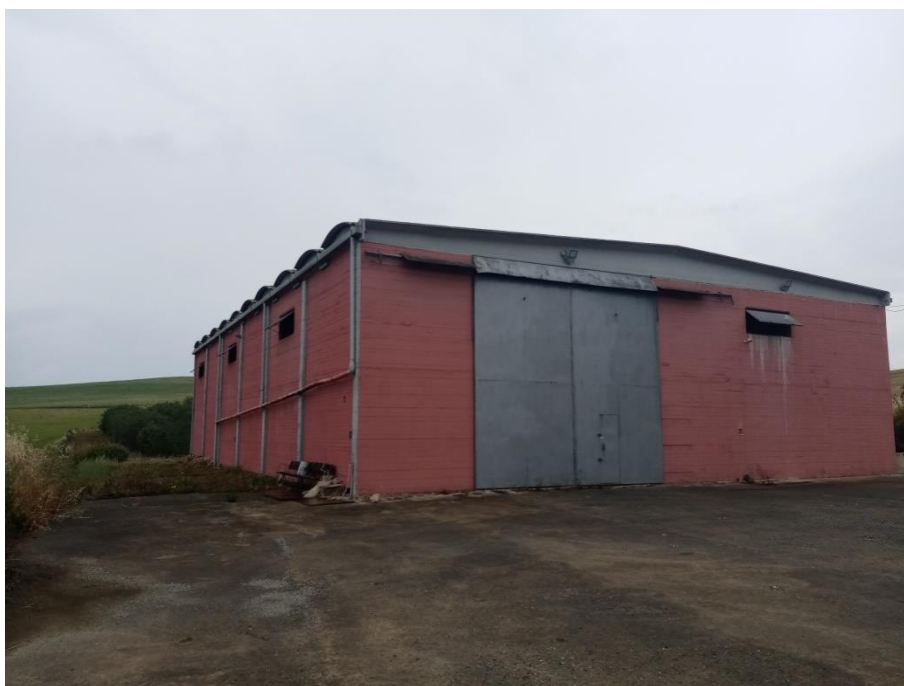
Foto 3 – Vista ingresso e laterale lungo il confine
