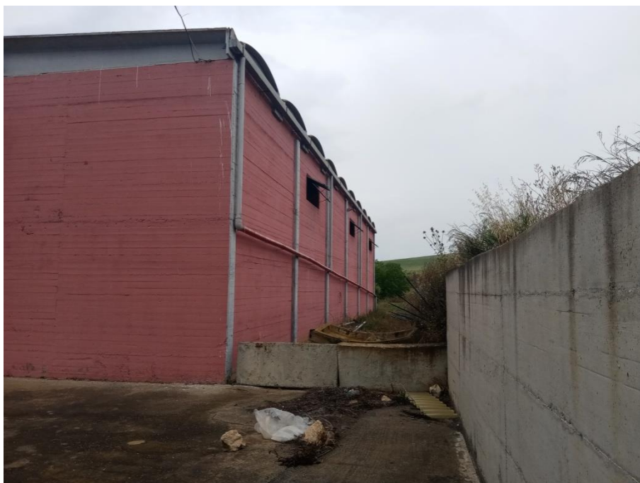
Foto 4 – Vista laterale lungo il confine
