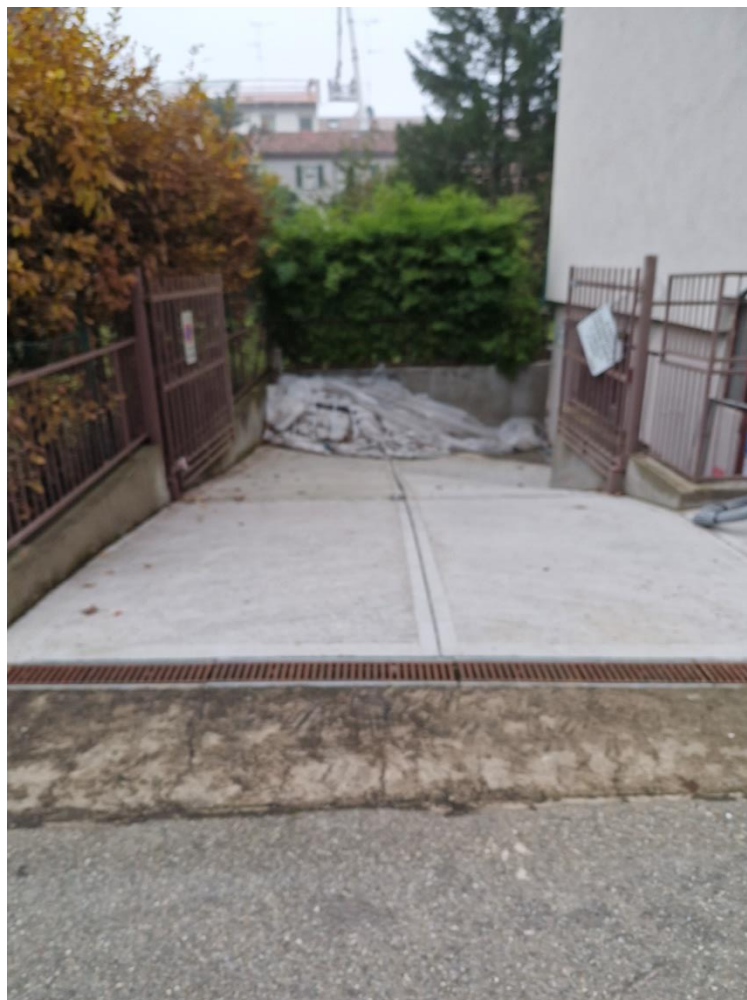
FOTO 2 – Ingresso condominiale autorimesse interrato
