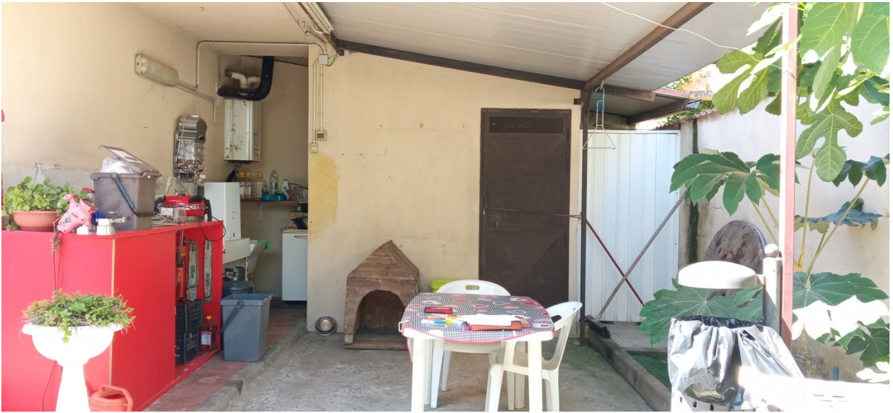
Deposito e tettoia
