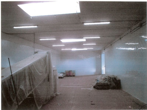
Retro locale "E"
