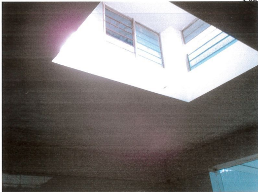
Lucernaio locale "E"
