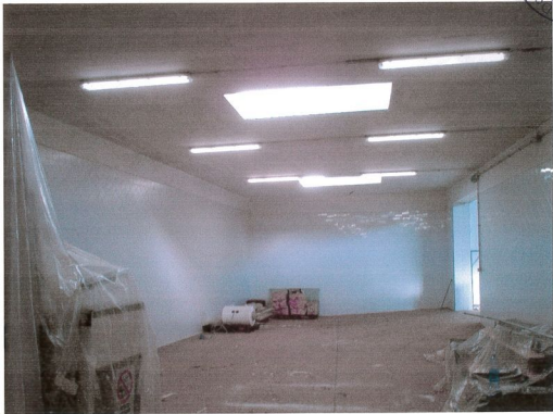
Retro locale "E"
