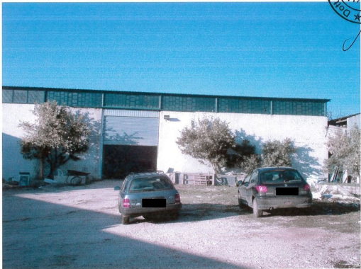
Ingresso locale "E"
