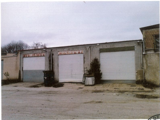
Ingresso locale "A"
