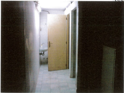
Servizi locale "A"
