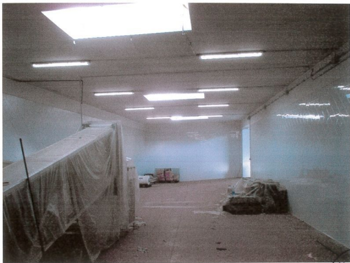
Retro locale "E"
