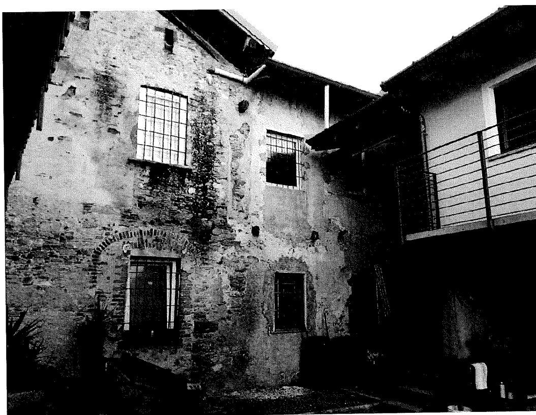
vista dalla corte confinante a ovest
