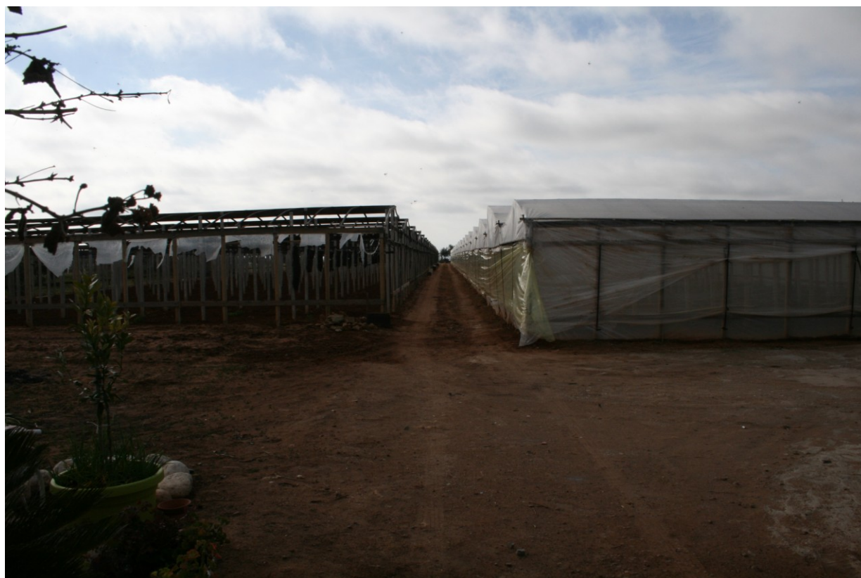
Foto n° 2 Vista dell'impianto serricolo posto sulle part.ile 169 e 155.
