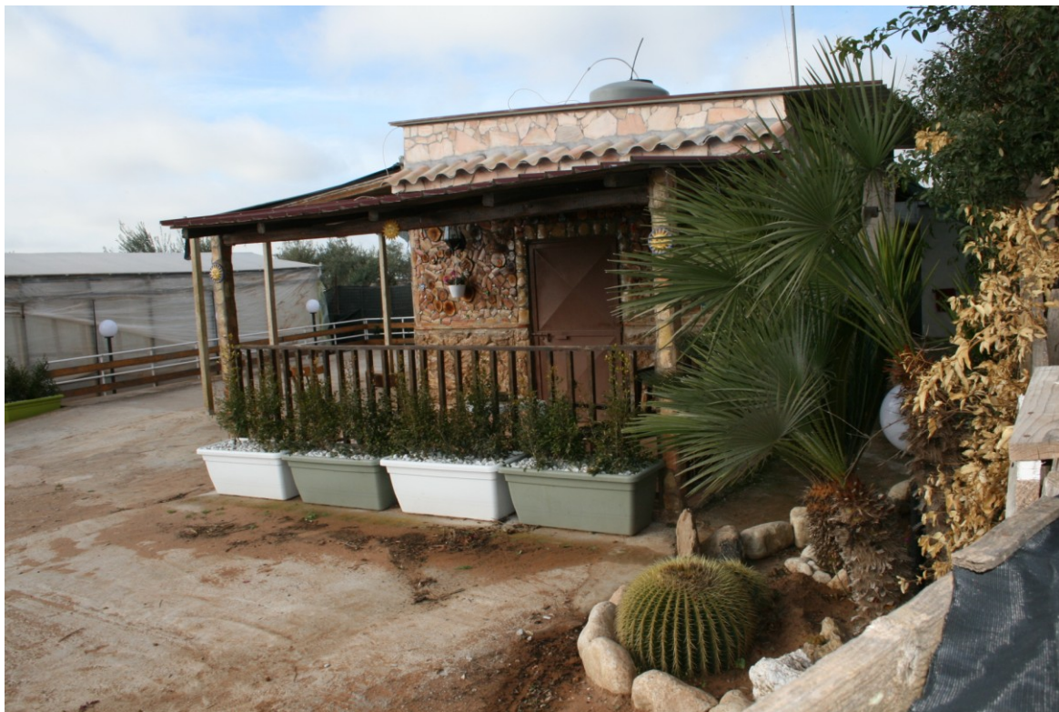
Foto n° 7 Vista del caseggiato costruito abusivamente sulla part.lla 169 adiacente l'ingresso al fondo.
