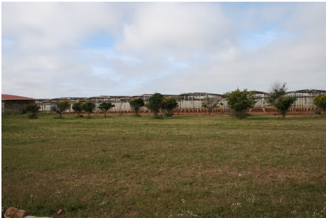
Foto n° 3 Vista dell'impianto serricolo con evidenza le serre non produttive e la mancanza della copertura.
