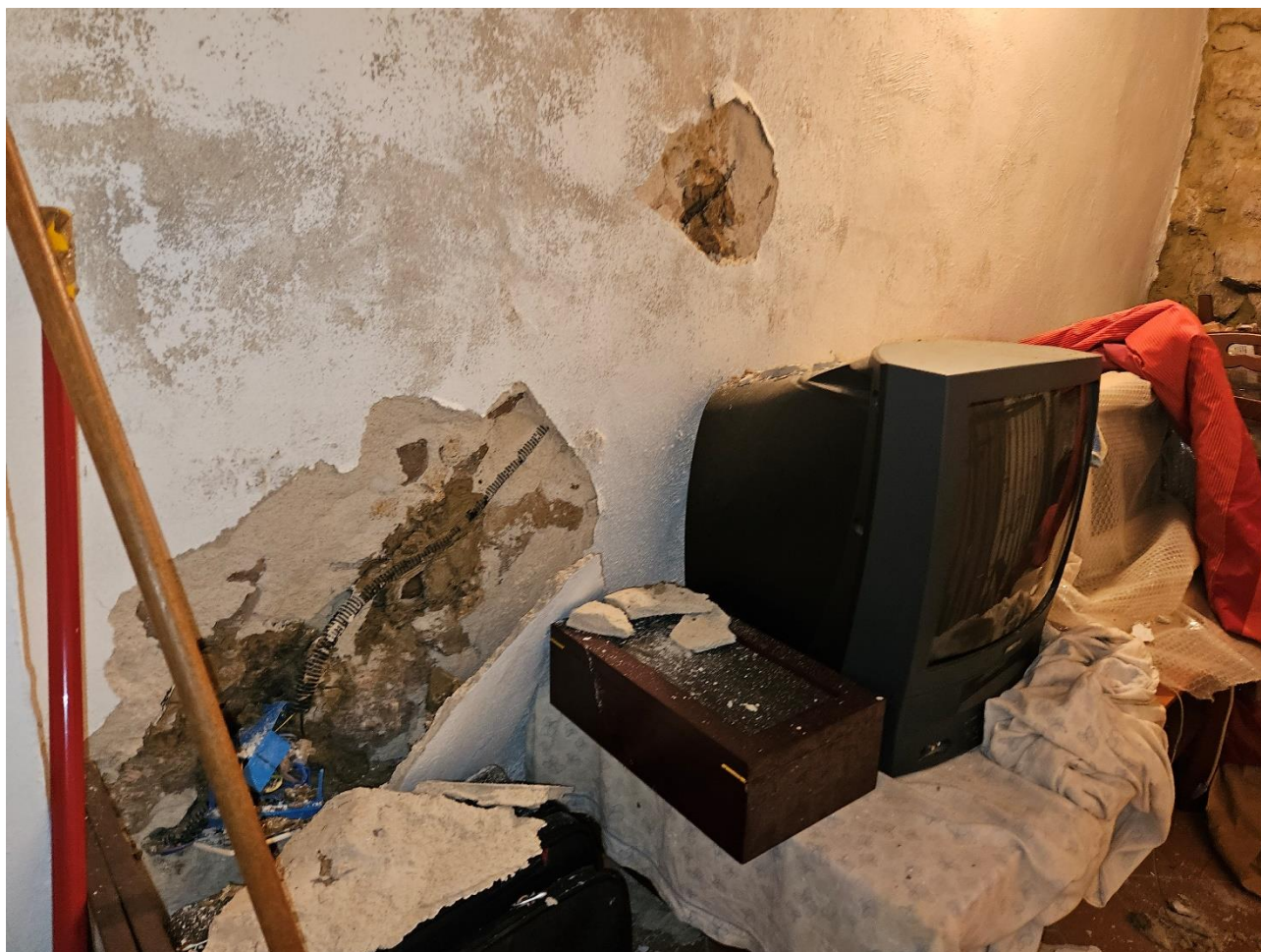
Parete da ripristinare
