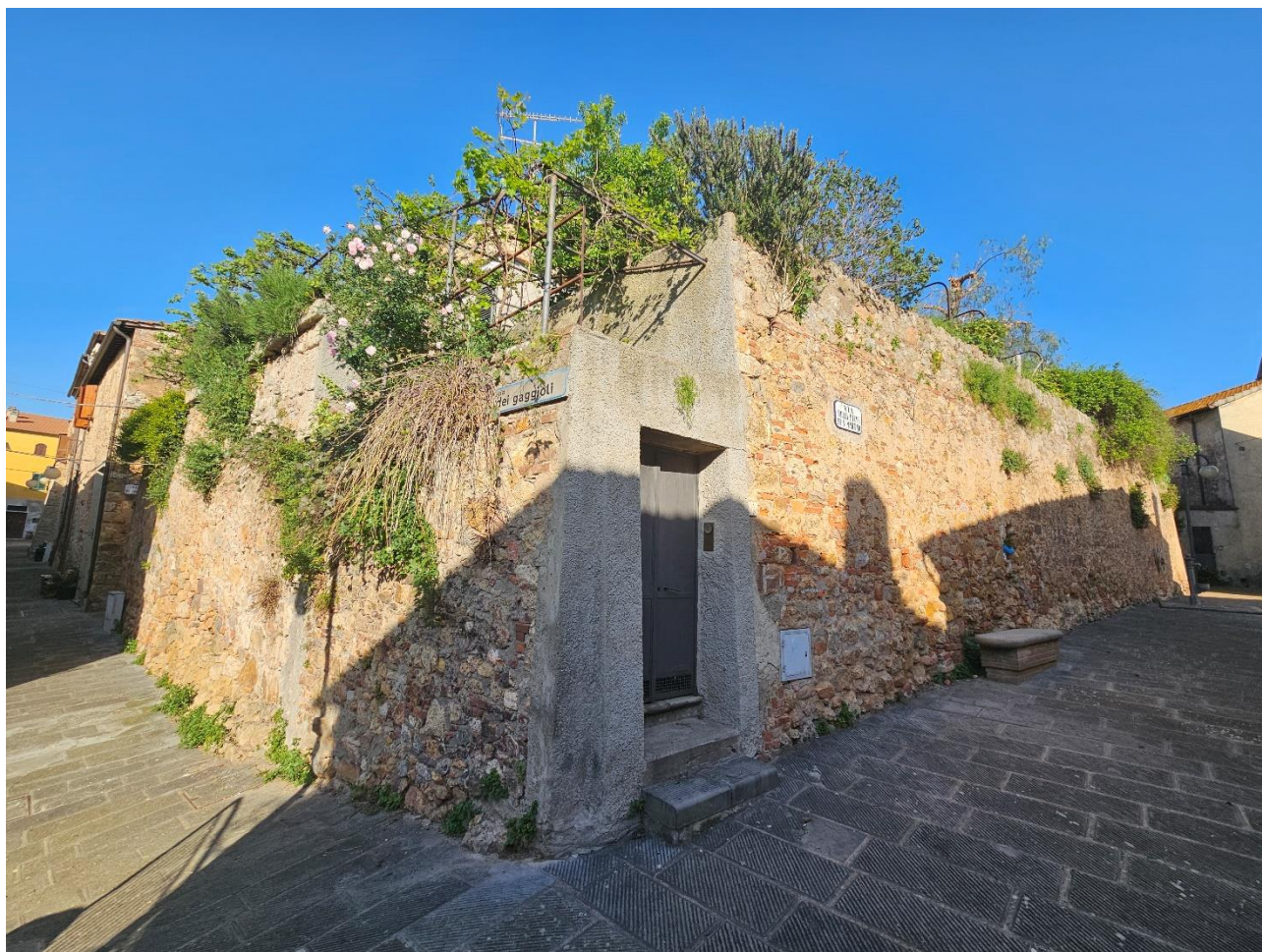
Vista porta di accesso alla scala esterna
