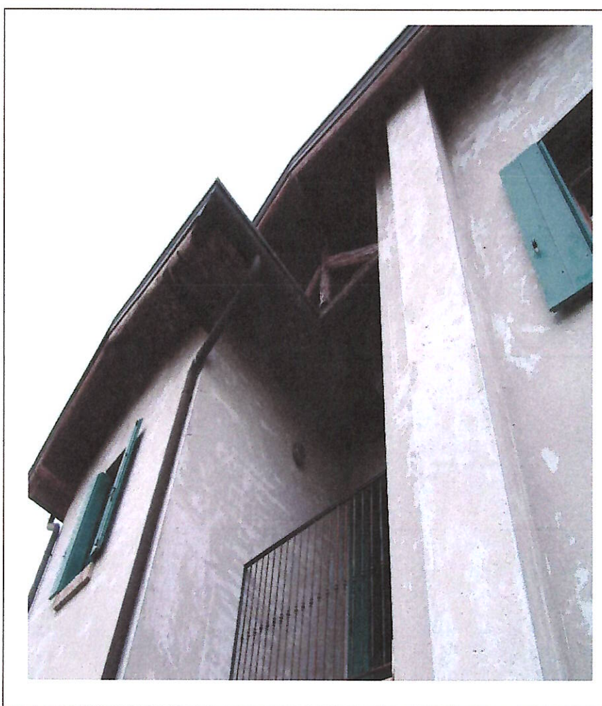
Particolare dei prospetti.
