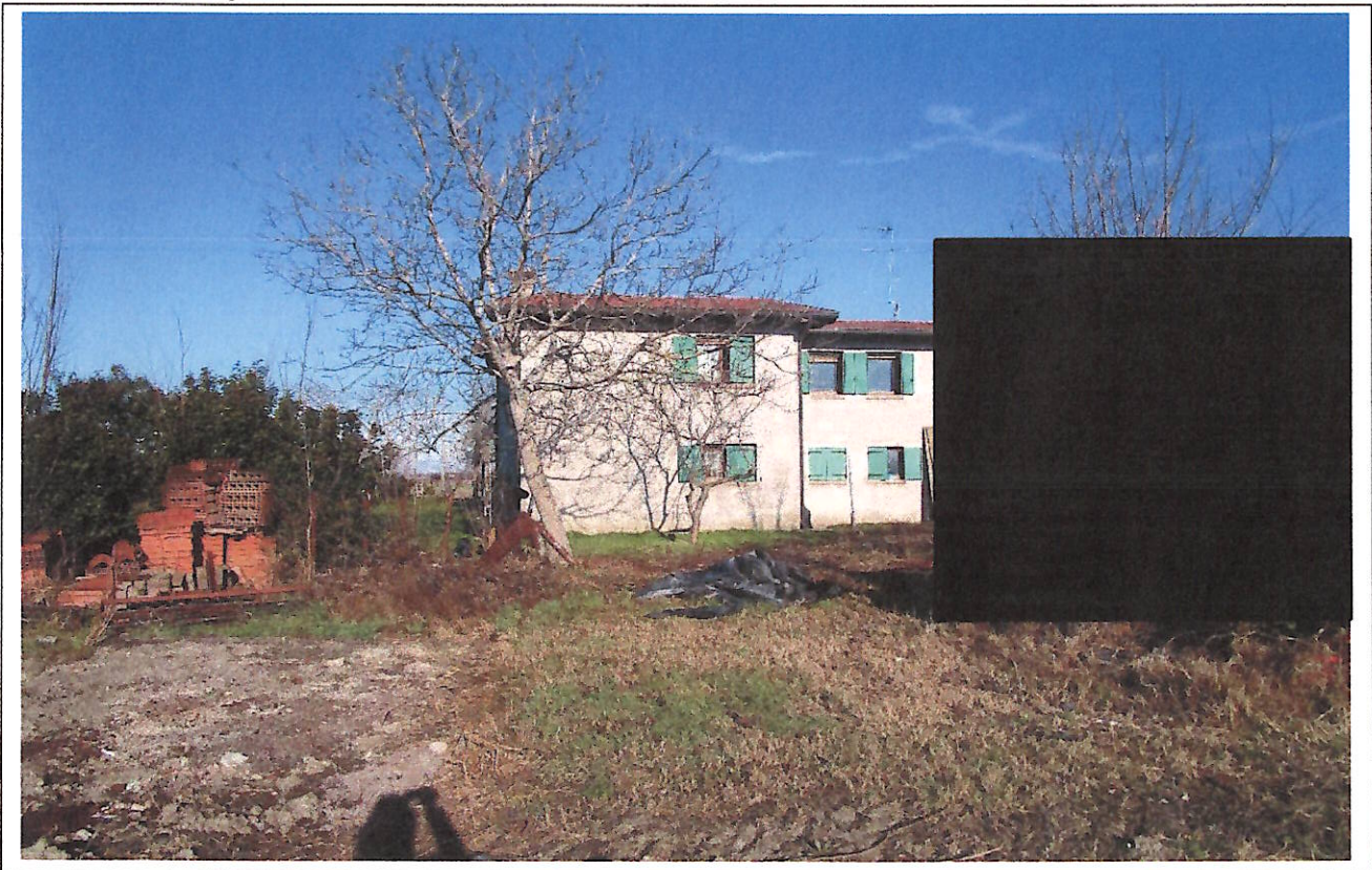
Particolare del materiale da rimuovere e del prospetto.
