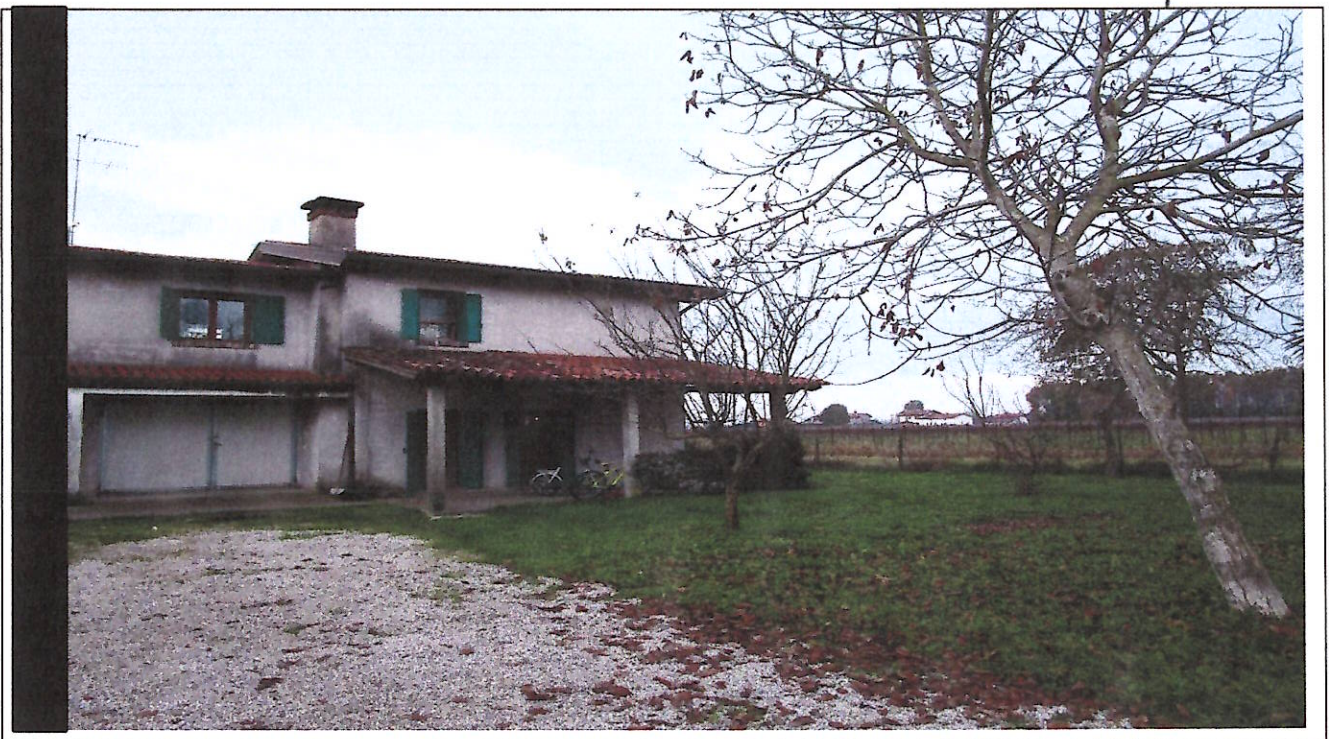
Particolare prospetto verso la viabilità – la copertura della pergola va rimossa.
